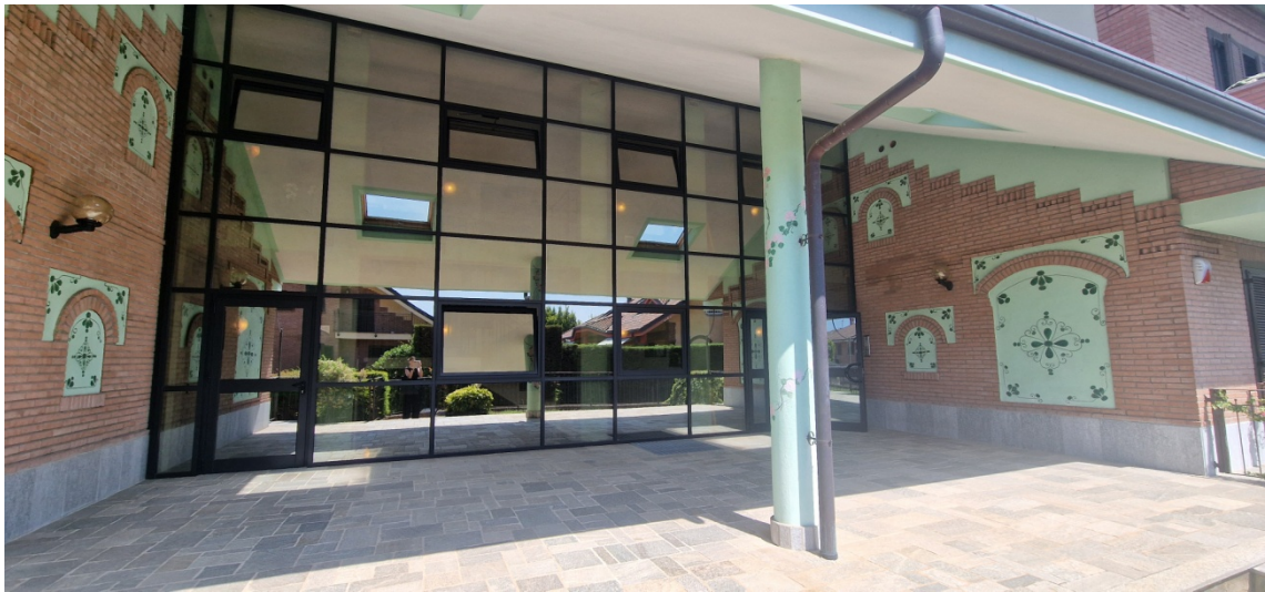
ATRIO INGRESSO CONDOMINIO
