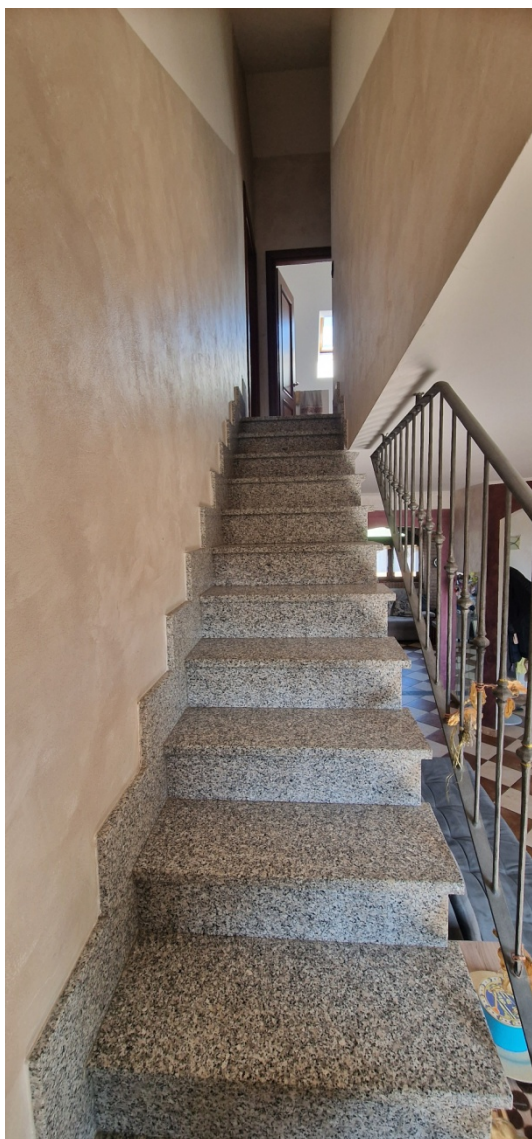
SCALA ACCESSO SOTTOTETTO
