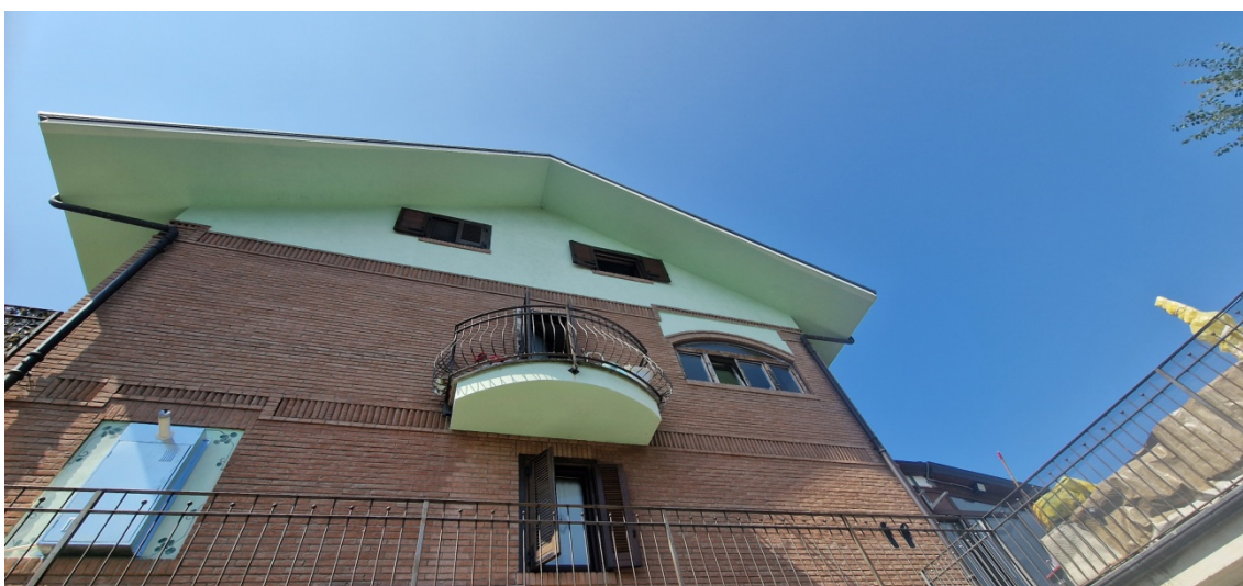
FACCIATA SU RAMPA INTERRATO
