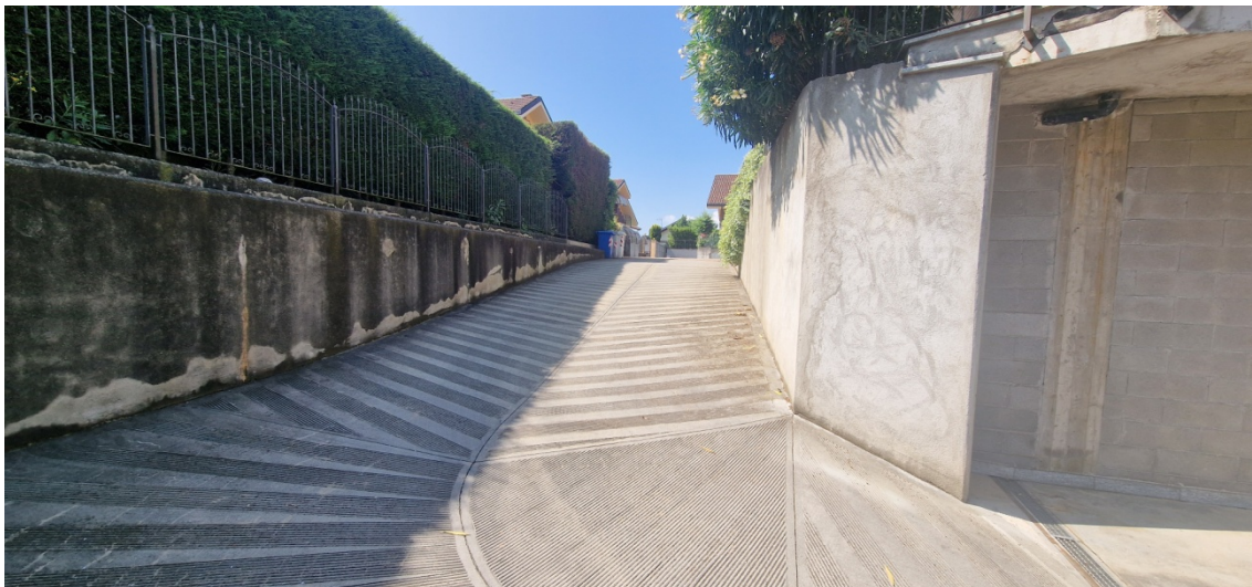
RAMPA DI ACCESSO BOX
