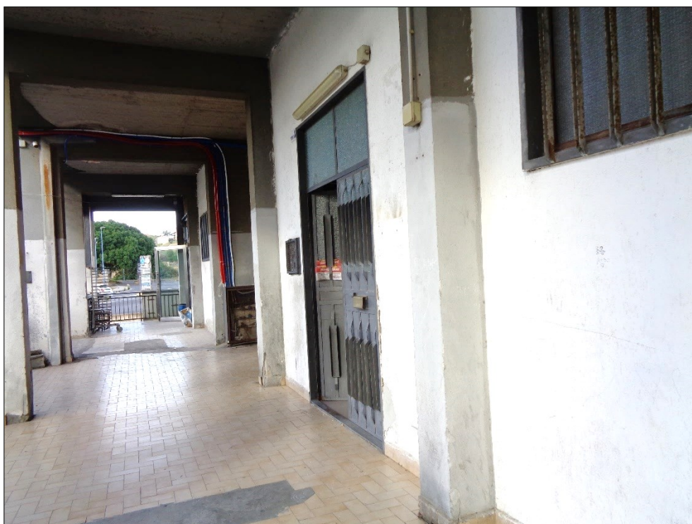
FOTO N° 3 – ACCESSO ALLA SCALA “A” DEL CONDOMINIO
