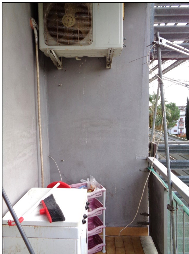
FOTO N° 21 – BALCONE LATO EST
