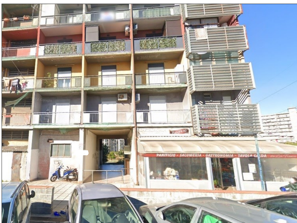
FOTO N° 2 – PROSPETTO SULL'AREA CONDOMINIALE
