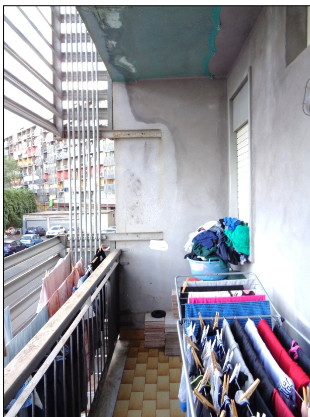
FOTO N° 20 – BALCONE LATO EST
