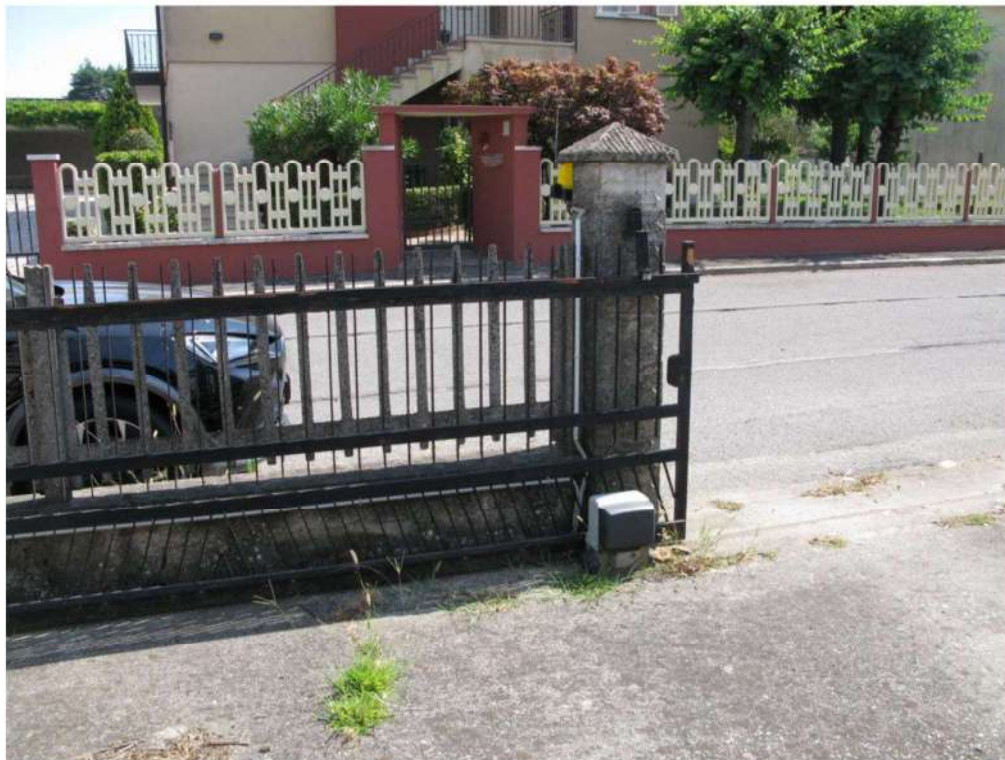
Foto n.26: Cancelli autorimessa part. 531
