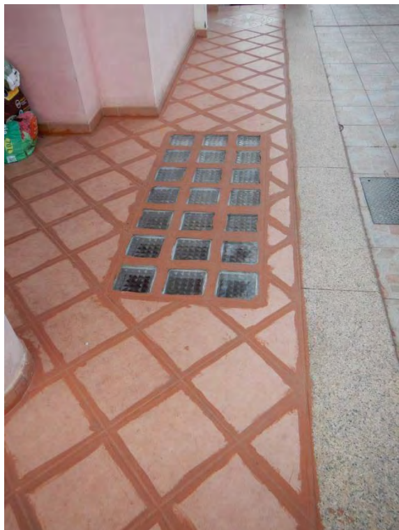
Foto 21: lucernai in vetro mattone (in progetto bocche di lupo per ventilazione locale interrato)
