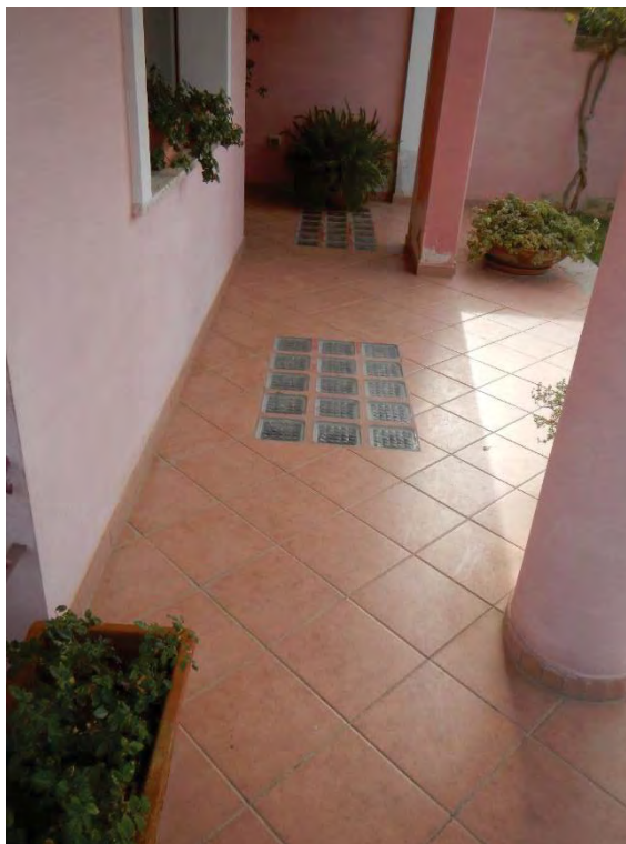
Foto 21: lucernai in vetro mattone (in progetto bocche di lupo per ventilazione locale interrato)
