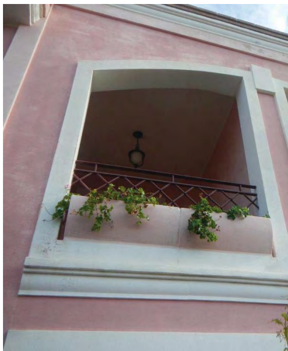
Foto 22: prospetto ovest (a) con dettaglio copertura continua in luogo della pergola ad aria passante prevista (b).
