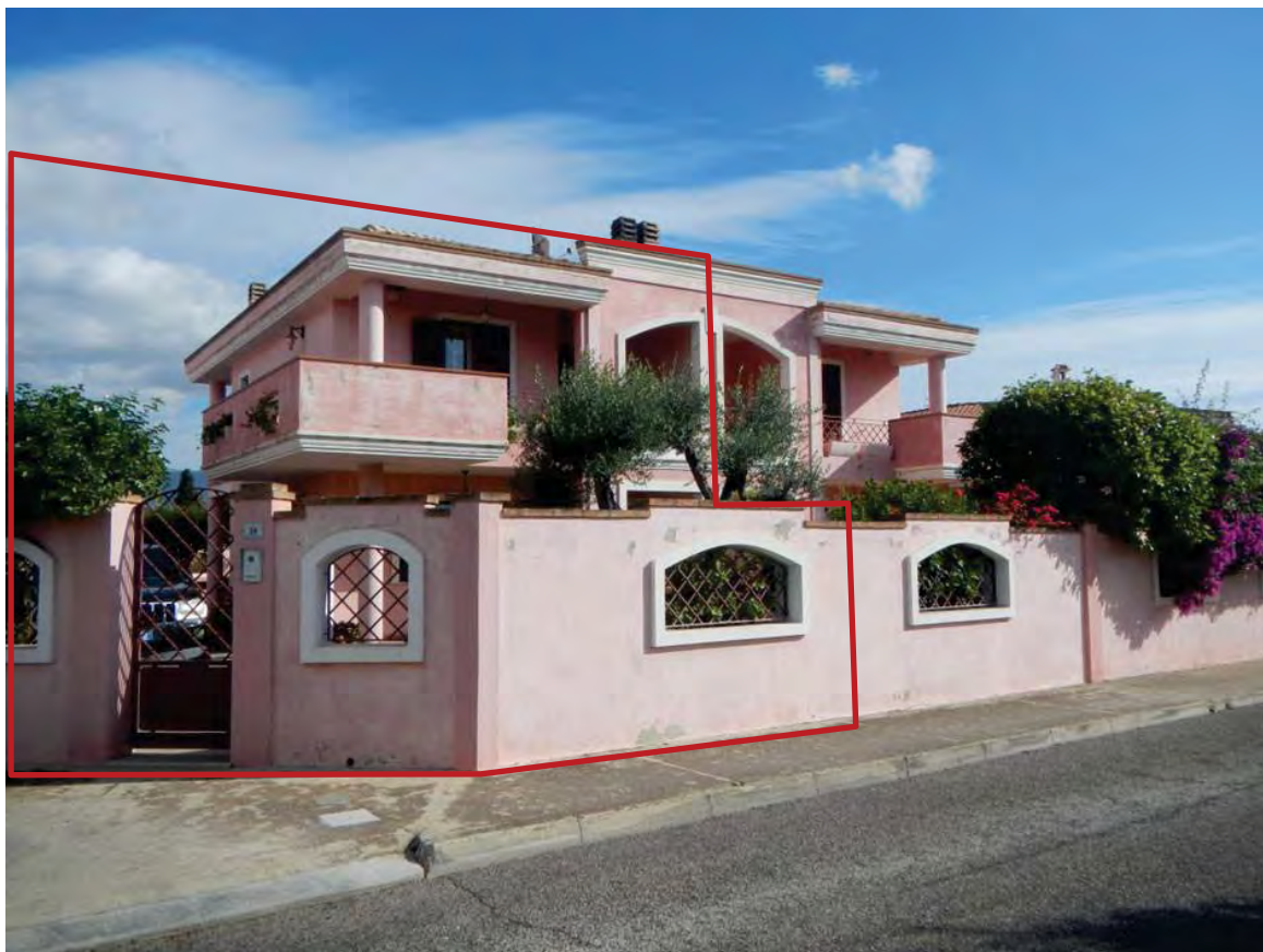
Foto 4: prospetto ovest, lato via Taormina, della porzione di villa bifamiliare corrispondente alla P.Illa 3036
