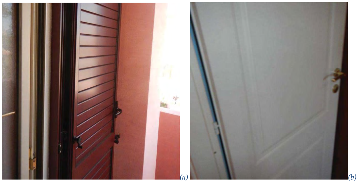
Foto 26: dettaglio infissi e serramenti esterni (a) e interni (b).
