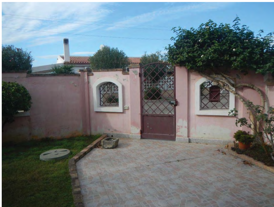
Foto 23: accesso pedonale lato via Taormina, la recinzione perimetrale è difforme da quanto previsto in progetto.
