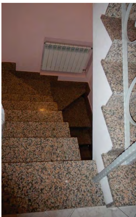
Foto 12: scala interna tra piano interrato e piano terra priva di protezione laterale (b)
