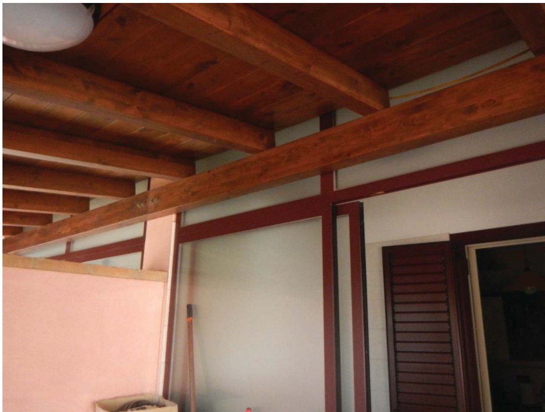
Foto 17: Tettoia in legno con copertura in tegole realizzata in continuità tra le due porzioni di edificio.
