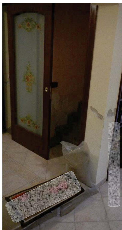
Foto 12: scala interna tra piano interrato e piano terra priva di protezione laterale (b)
