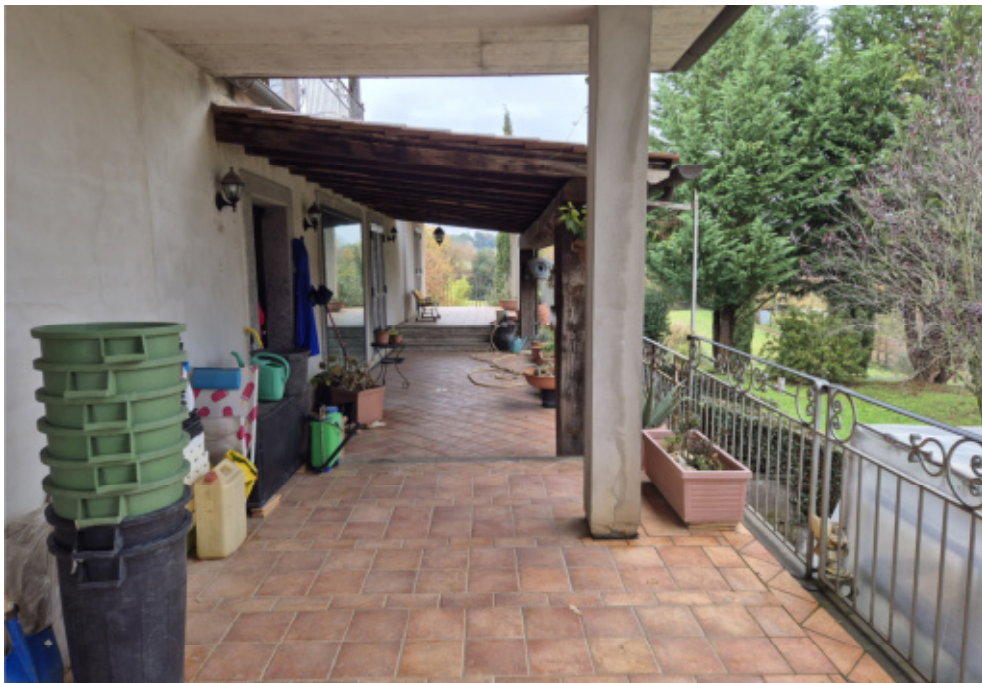
Area esterna / portici e terrazzi al piano terra
