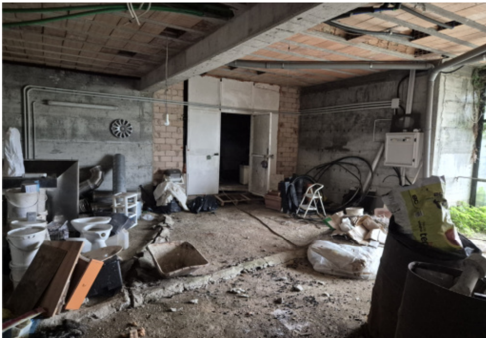
Piano seminterrato - magazzini e garage da completare
