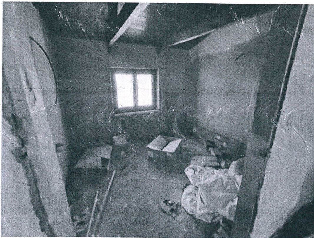
Vista interna locali piano sottotetto – locale sottotetto e bagno ( predisposizione impianti )
