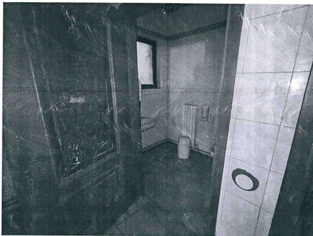
Vista interna locali piano terra – bagno e antibagno a servizio del salone
