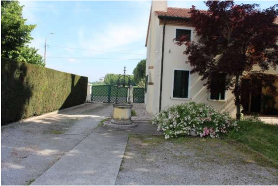
1 – Prospetto interno e accesso carraio
