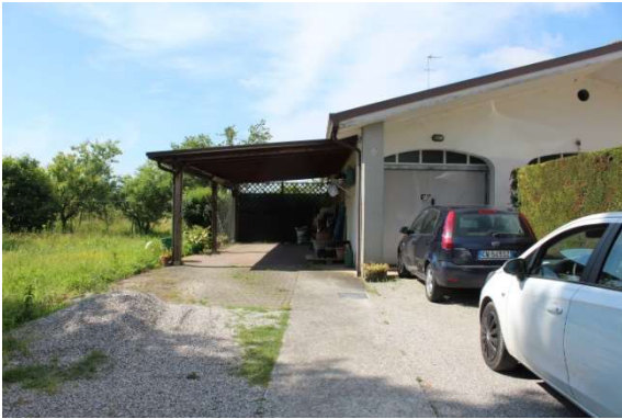
3 – Annesso rustico e tettoia abusiva
