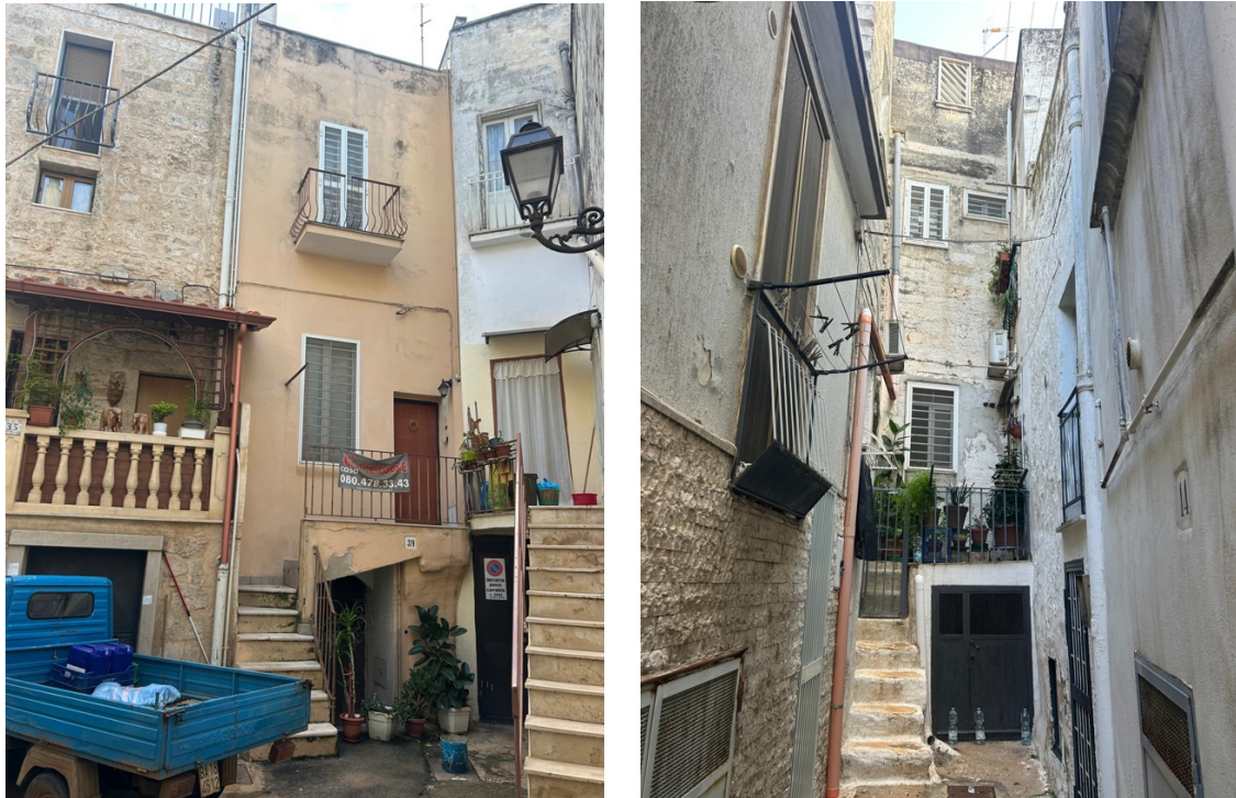
Foto 1 e 2: fabbricato "da cielo a terra" oggetto di esecuzione immobiliare
