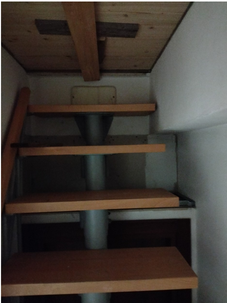
Foto n. 010 – Chiusura foro del vano scala solaio piano terra
