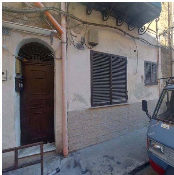
FOTO 3 – Prospetto via Colonna Rotta
