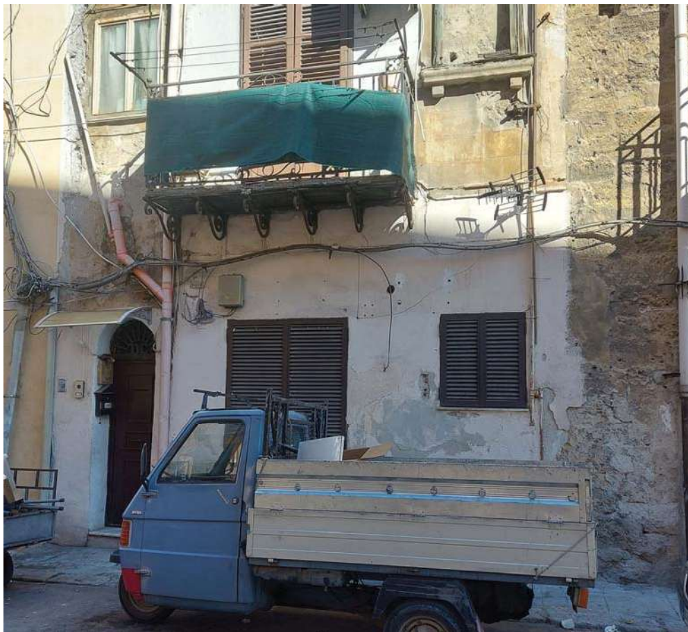
FOTO 2 – Prospetto via Colonna Rotta n. 255 – Palermo
