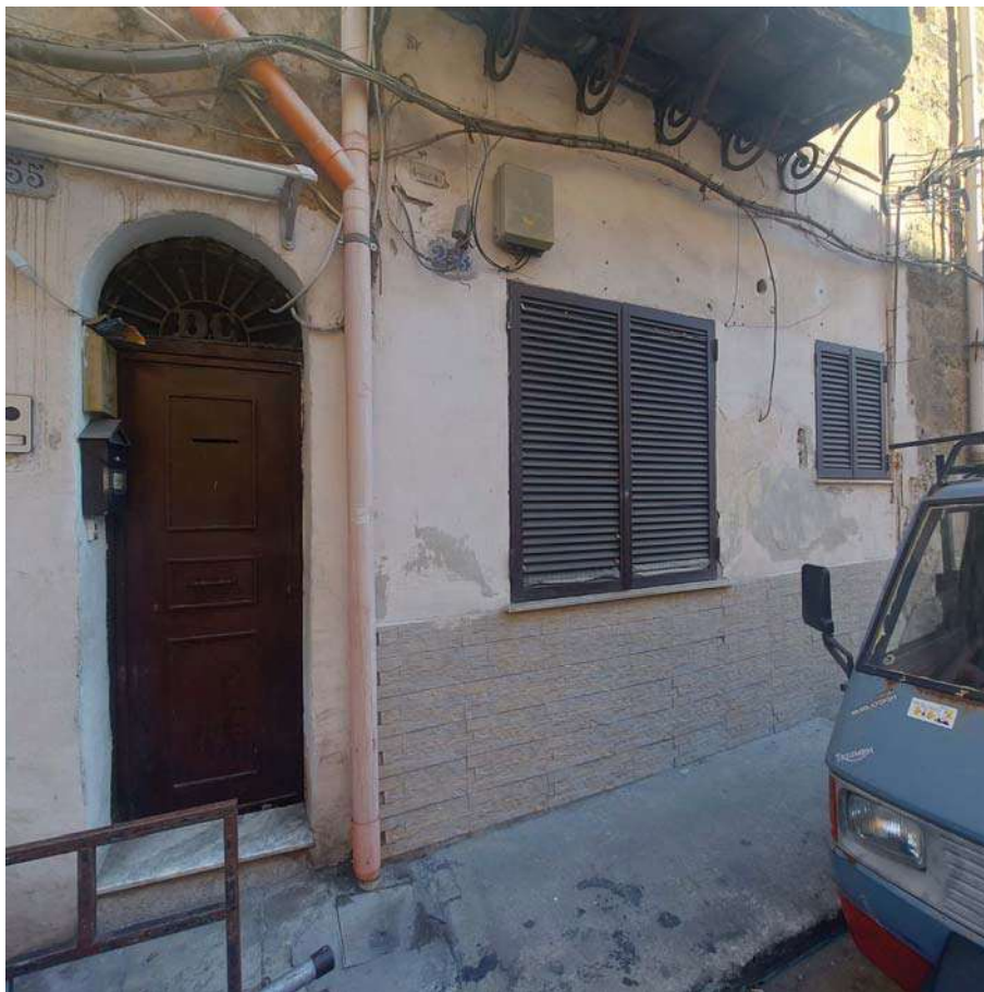
FOTO 3 – Prospetto via Colonna Rotta n. 255 – Palermo
