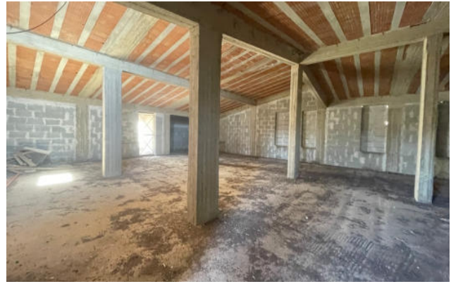
vista del locale piano secondo
