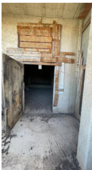
vista ingresso piano 1
