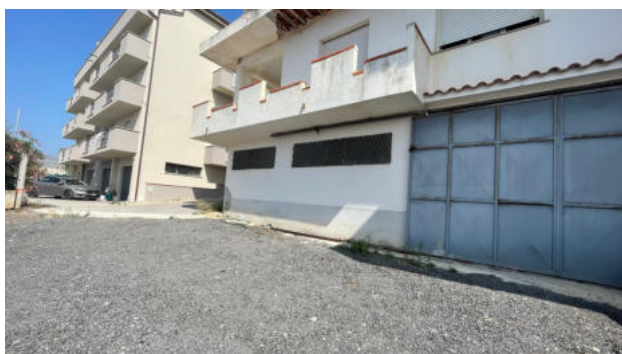
Vista del piano seminterrato – locale parcheggio
