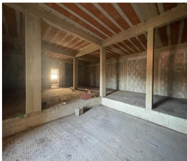
vista del locale piano primo
