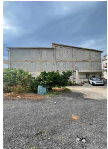
vista prospetto retrostante
