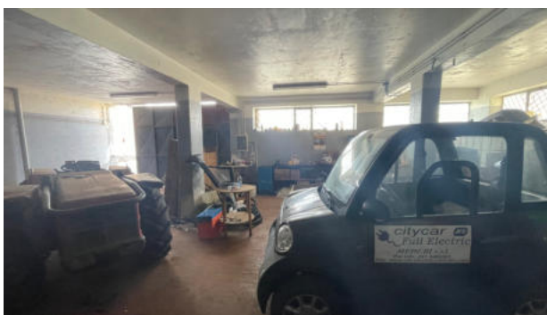
Vista del piano seminterrato – locale parcheggio
