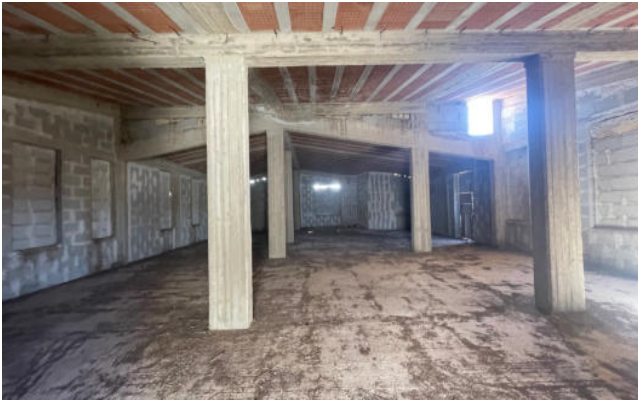
vista del locale piano secondo
