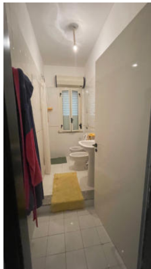
vista del vano wc 3
