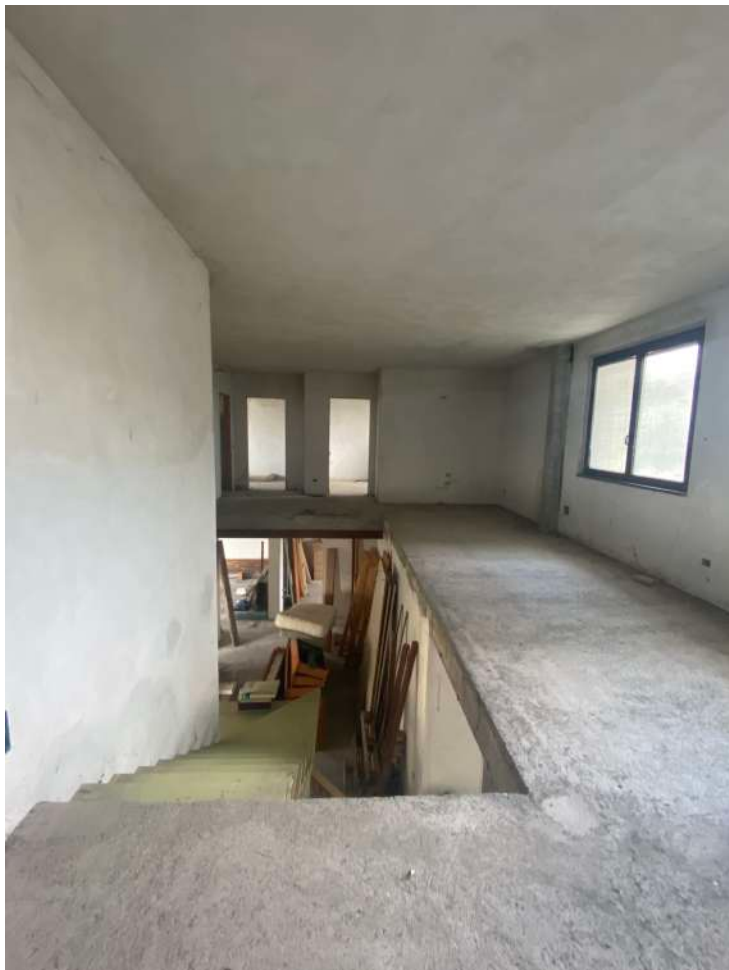
Foto 07: SOPPALCO PIANO PRIMO, ACCESSO ALLE CAMERE
