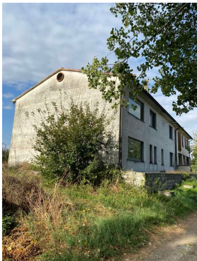
Foto 02: VISTA DEL PROSPETTO EST
