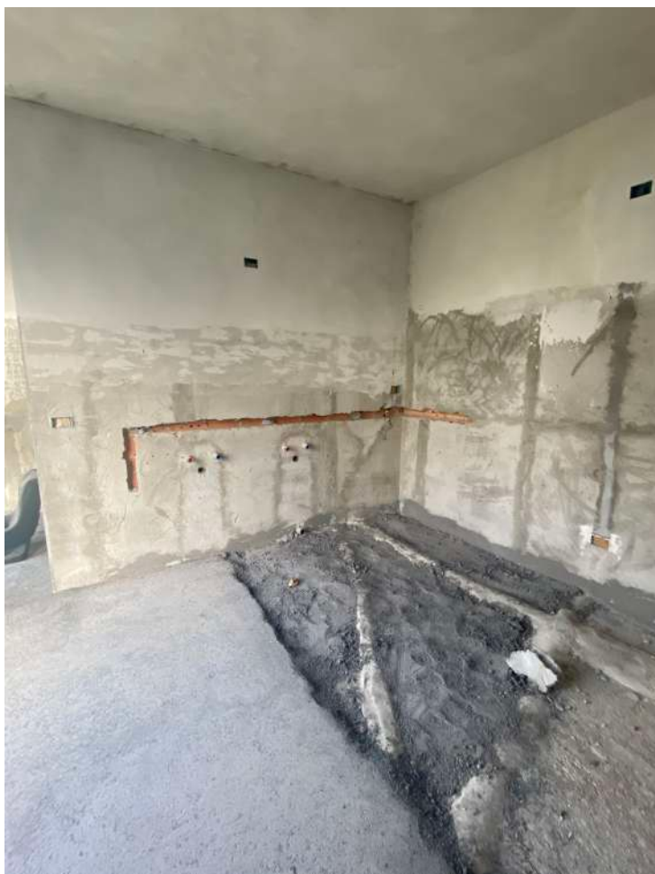
Foto 08: BAGNO 01 PIANO PRIMO
