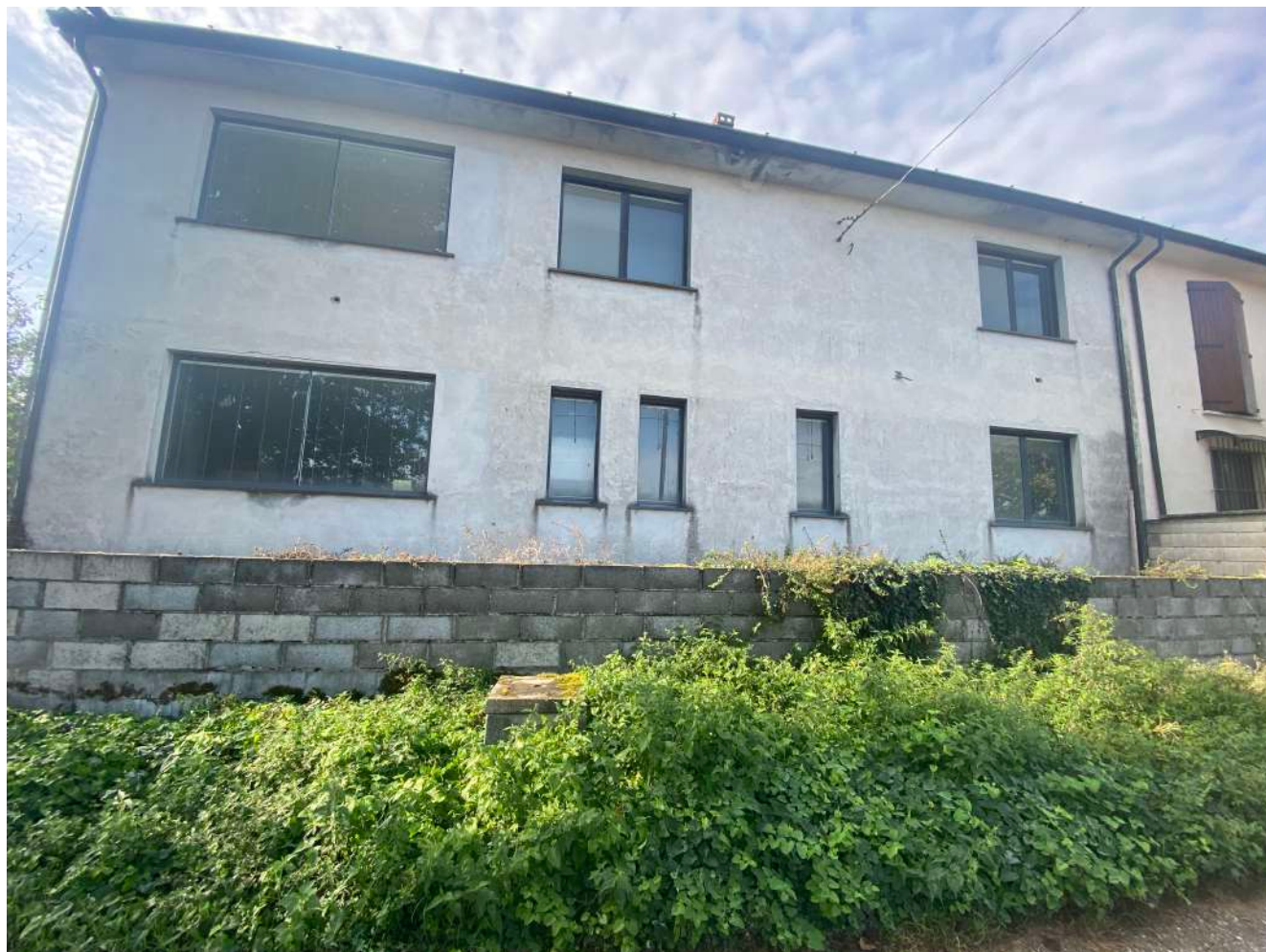
Foto 01: VISTA DA STRADA DI ACCESSO ABITAZIONE – PROSPETTO NORD
