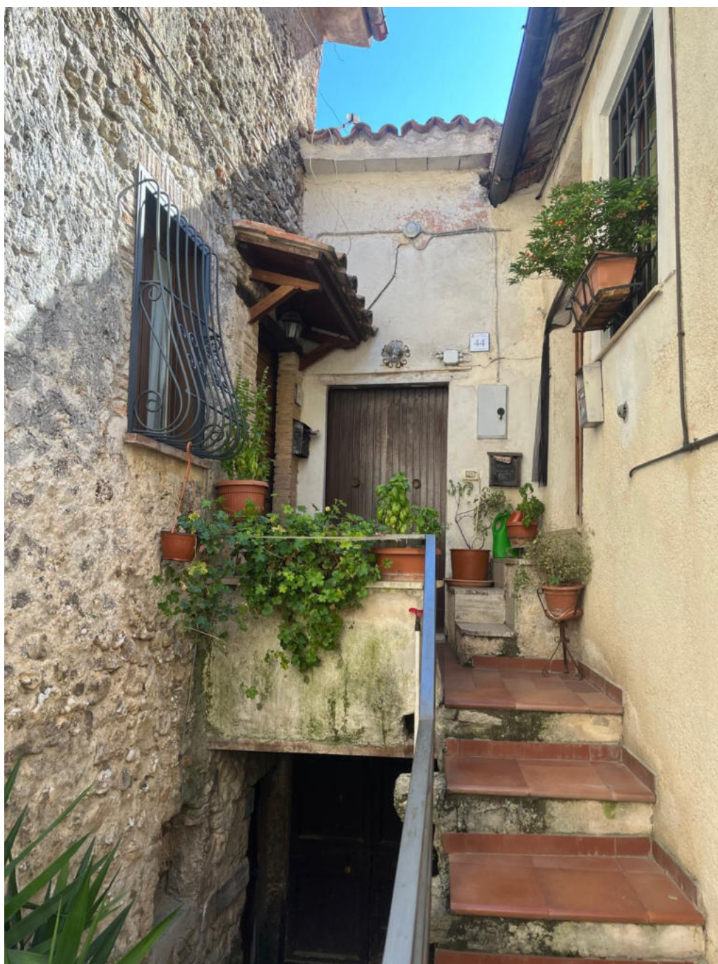
Foto n. 1 – Prospetto del fabbricato
