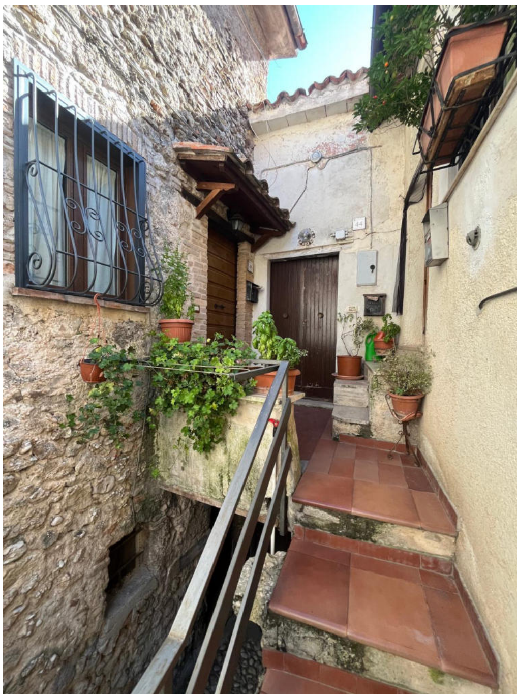
Foto n. 2 – Prospetto del fabbricato
