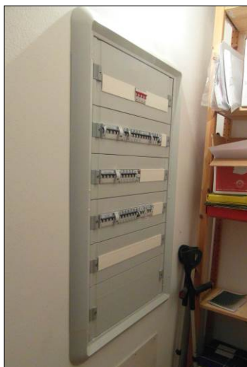
foto 2 – Q.E. Loc. Ripostiglio
