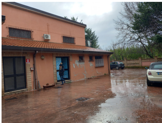
Foto 6: Ingresso abitazione-Piano Terra
