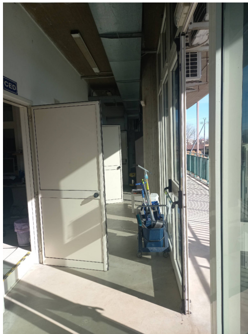
Foto 56: Ingresso CED Piano Primo
