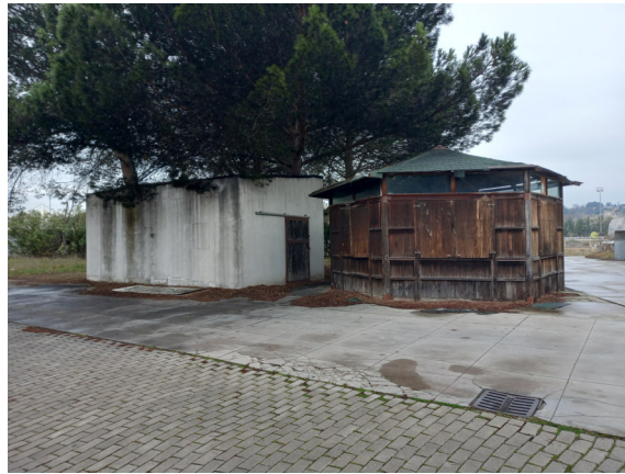
Foto 51: Fabbricato 4 - Magazzino e Deposito
