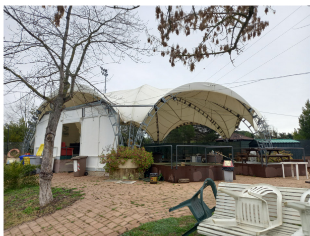
Foto 23: Tensostruttura Lago pesca sportiva
