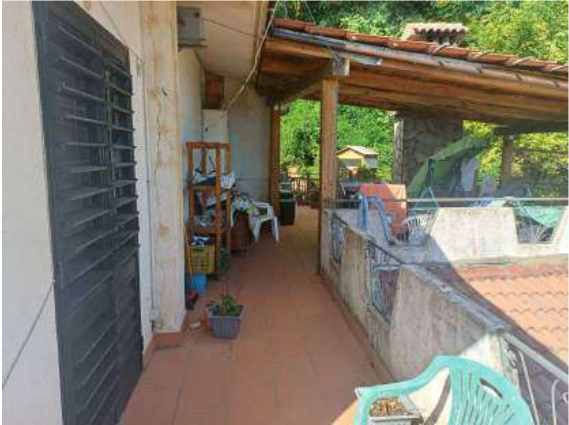
Foto N.3: Prospetto fabbricato angolo Nord.
