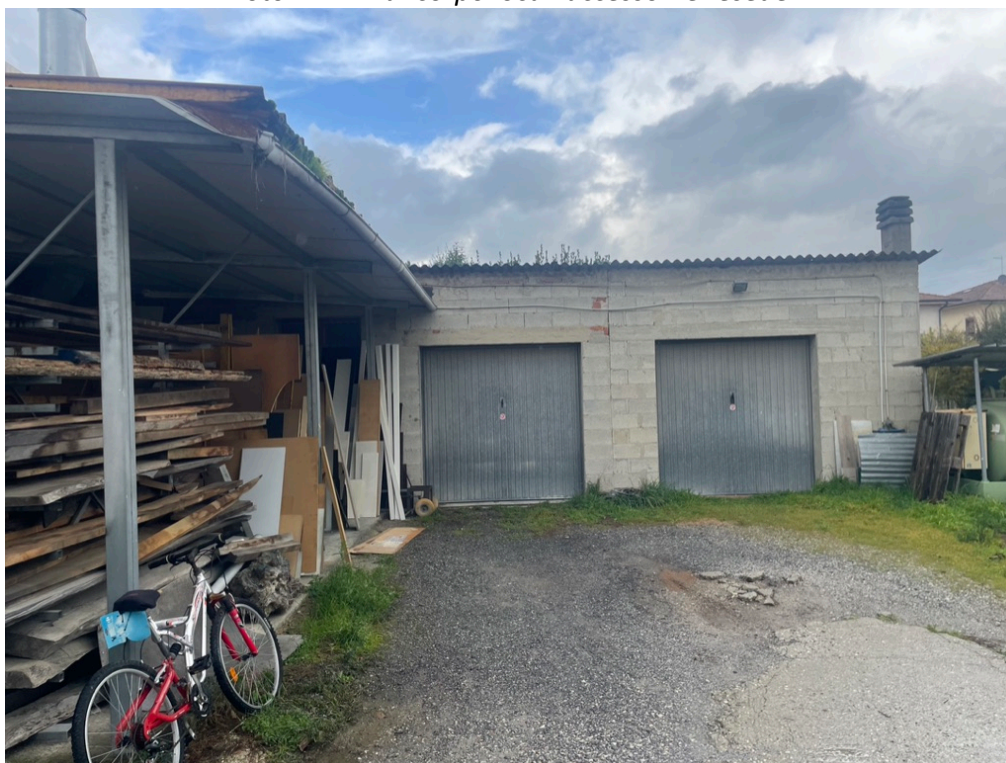
Foto 11 – Avancorpo locali accessori e resede
