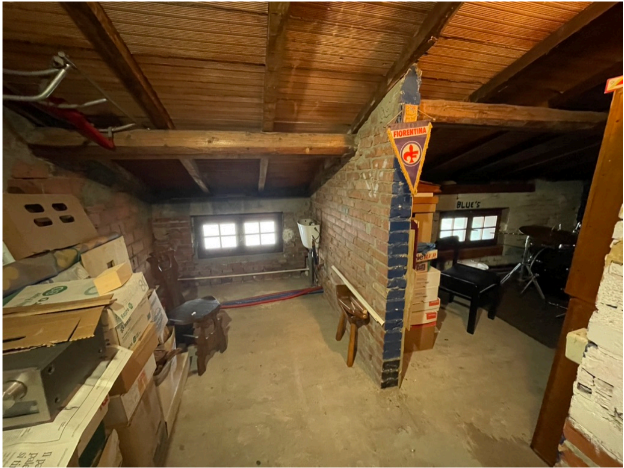
Foto 23 – Soffitta P2 (corpo B)
