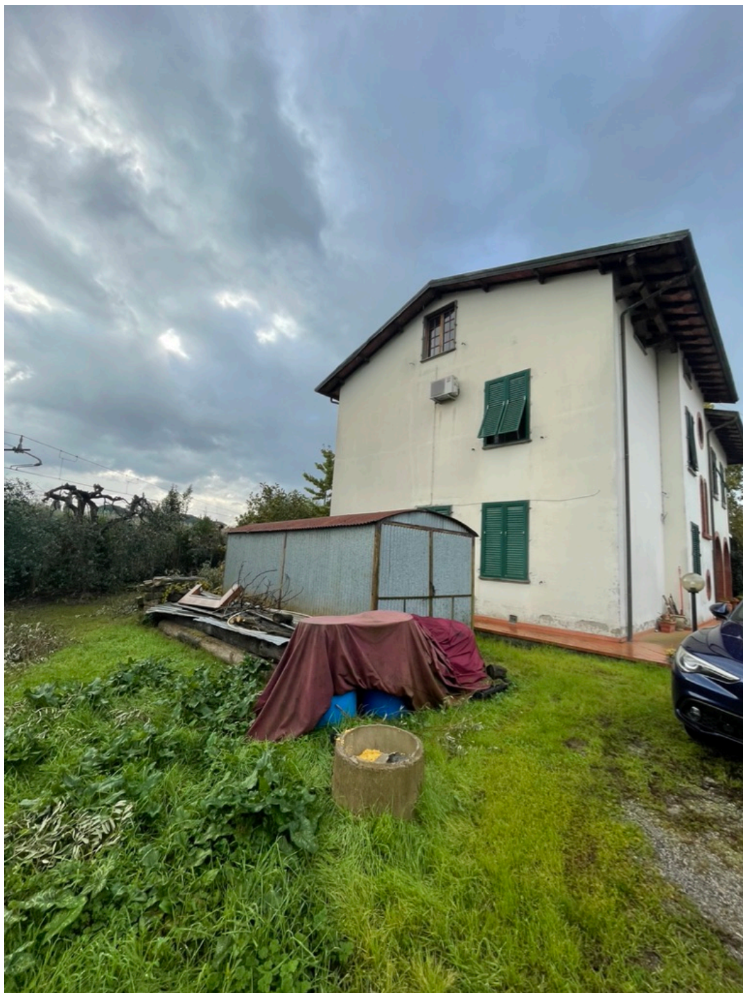
Foto 24 – manufatto per rimessa (corpo C)
