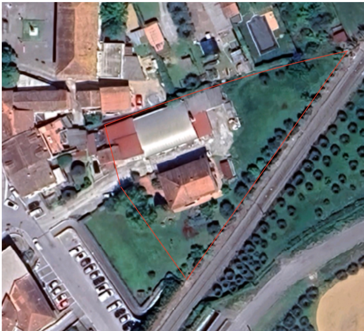
Foto 25 – Terreni e resede (corpo D)
