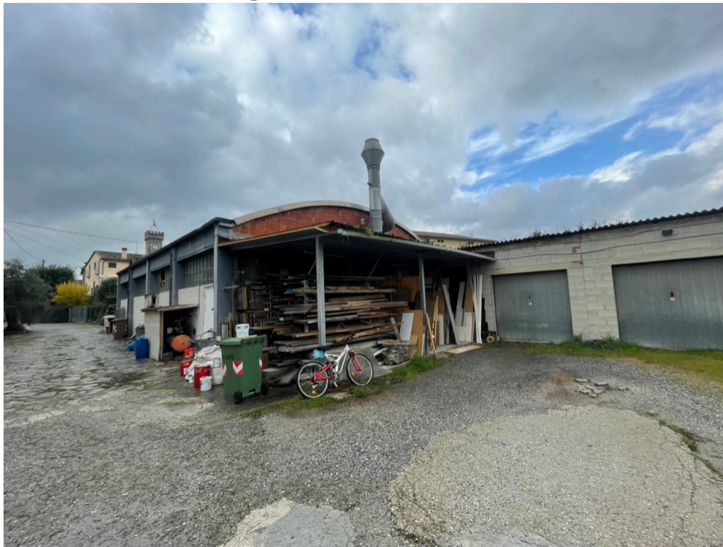
Foto 10 – Vista d'insieme con accesso e locali accessori
