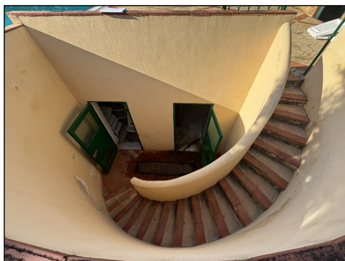
Foto 13 – Veduta dei locali tecnici interrati
