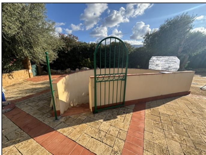
Foto 12 – Scala di accesso ai locali tecnici
