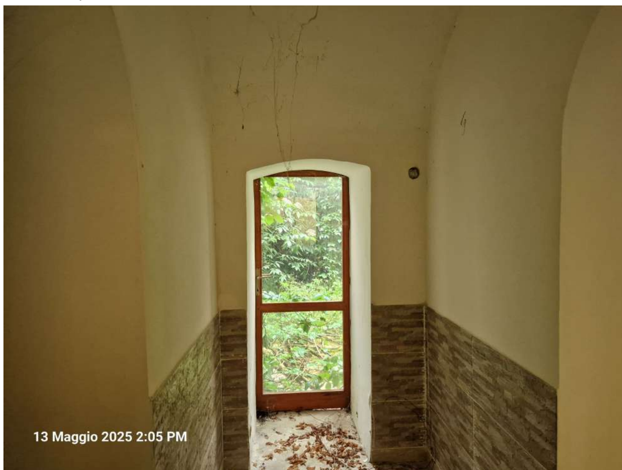
Foto n. 14: Locale commerciale – Disimpegno (porta in legno di accesso al cortile)
