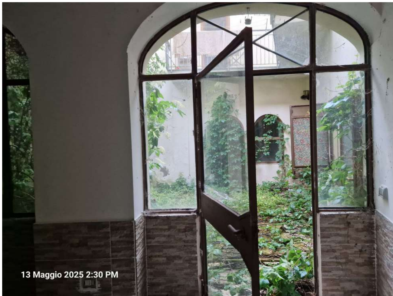
Foto n. 19: Locale commerciale – Deposito (porta finestra di accesso al cortile)
