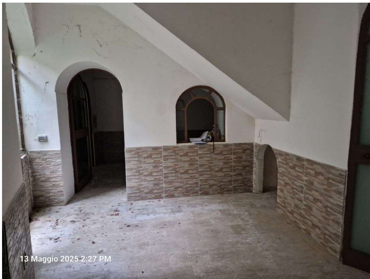
Foto n. 18: Locale commerciale – Deposito
