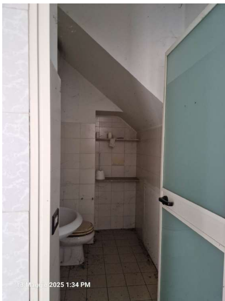
Foto n. 8: Locale commerciale – Bagno 2
