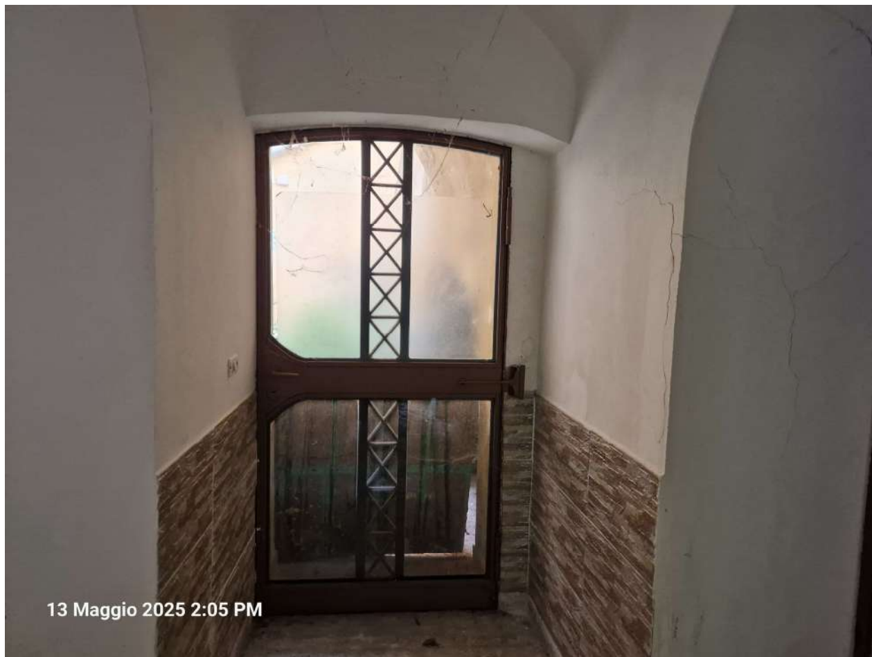
Foto n. 13: Locale commerciale – Disimpegno (porta di collegamento con l’androne del Fabbricato al civico 34)
