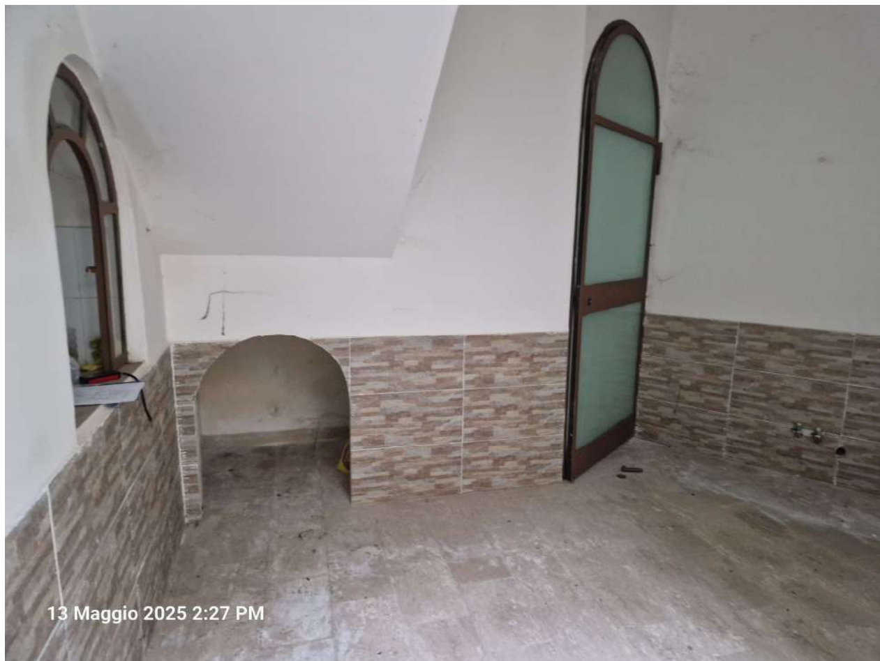
Foto n. 17: Locale commerciale – Deposito e Ripostiglio
