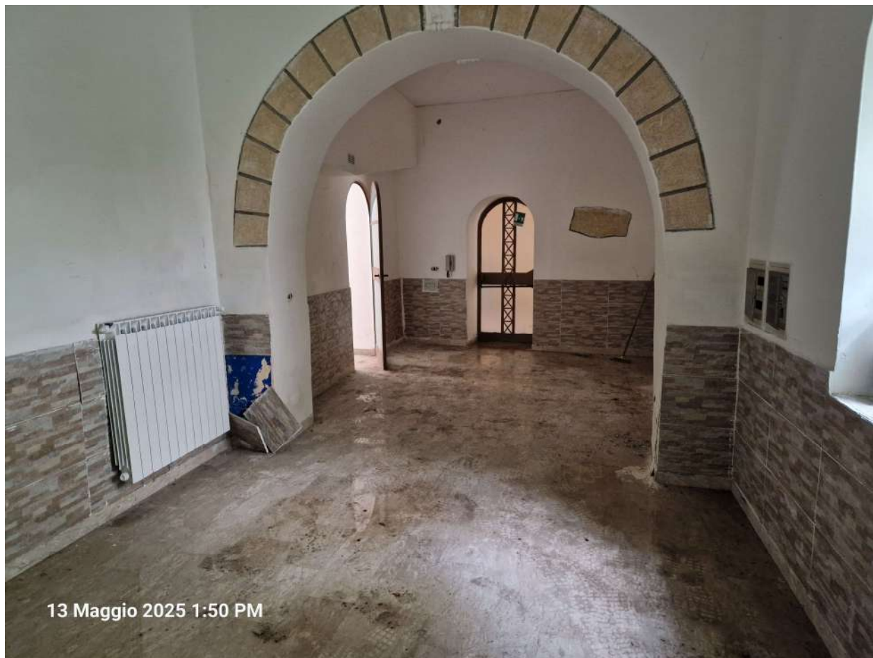
Foto n. 11: Locale commerciale – Locale 1
