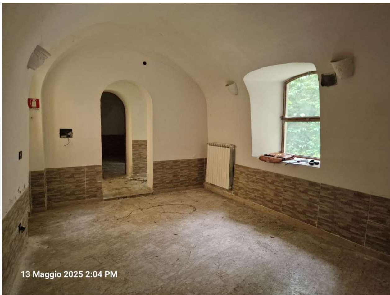
Foto n. 12: Locale commerciale – Locale 2
