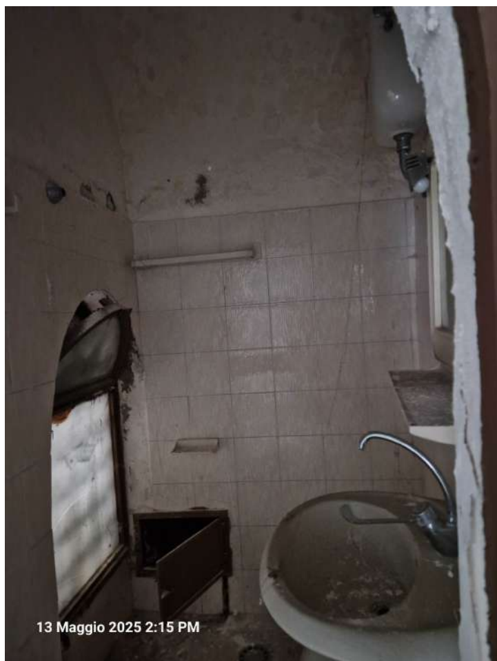
Foto n. 16: Locale commerciale – Bagno 3
