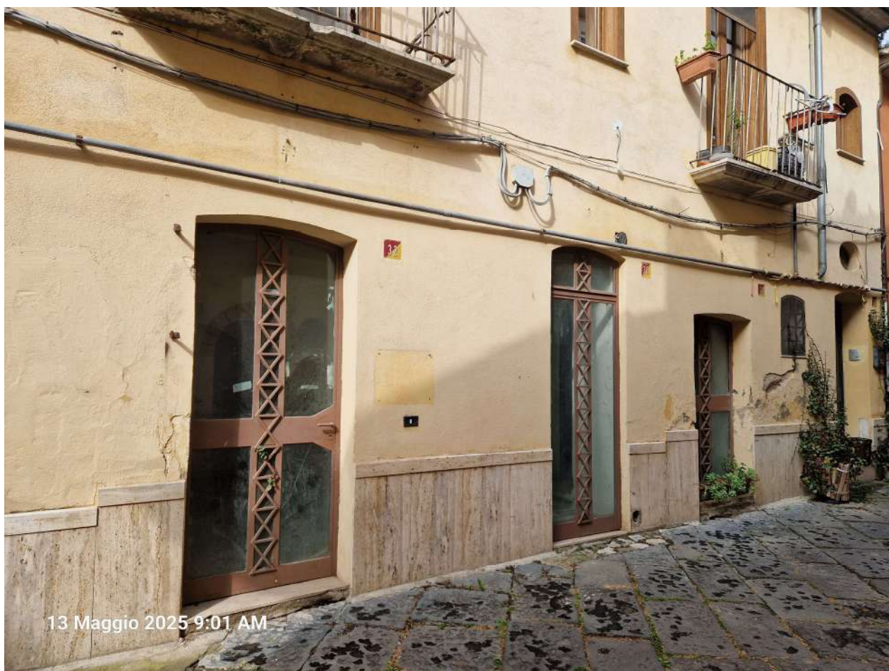
Foto n. 2: Locale commerciale ingresso lungo Vicolo III Triggio al civico 32
