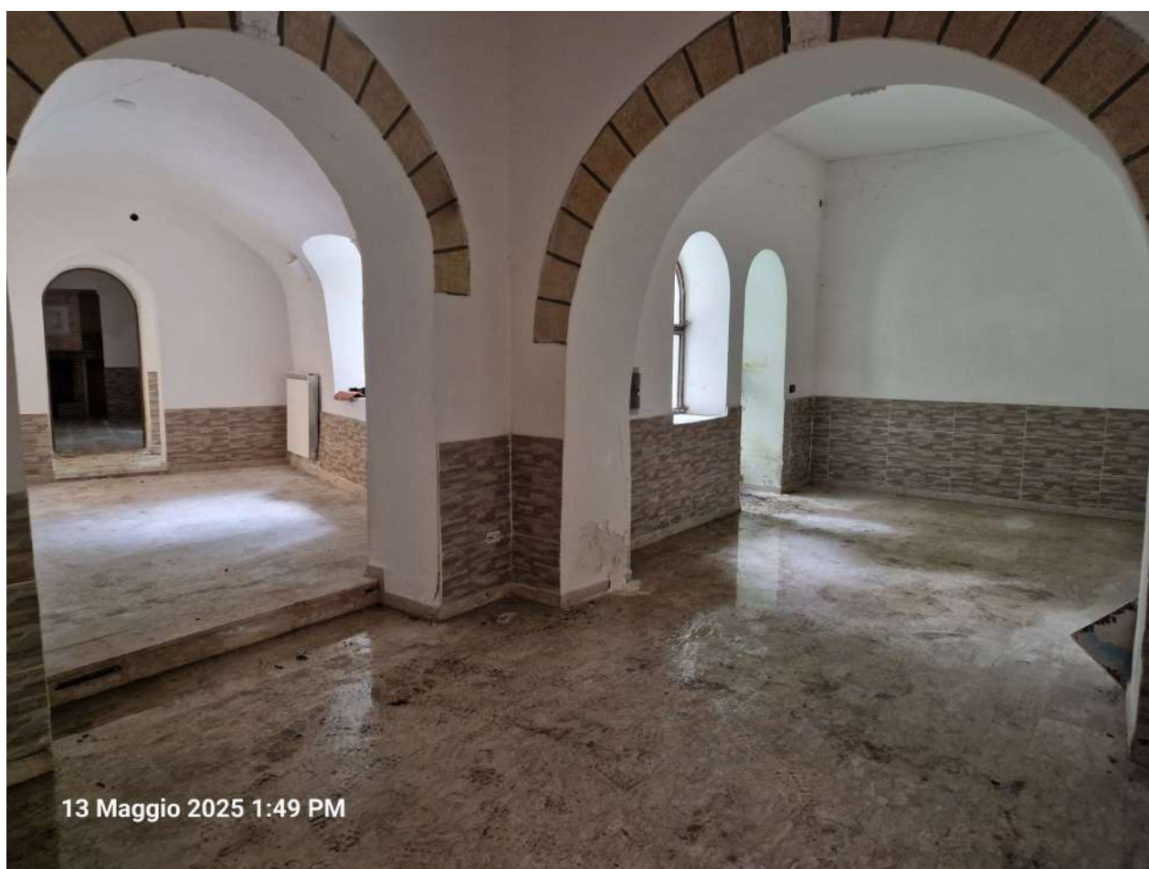
Foto n. 10: Locale commerciale – Locale 1 e Locale 2
