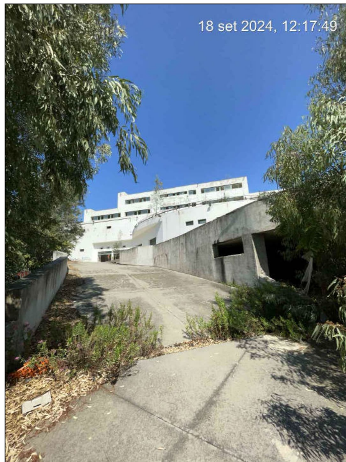
Foto 4 -Esterno Complesso Commerciale
