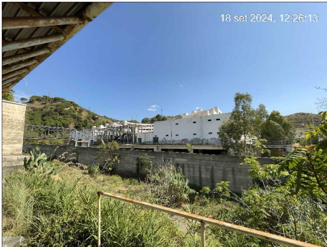
Foto 3 - Esterno Complesso Commerciale
