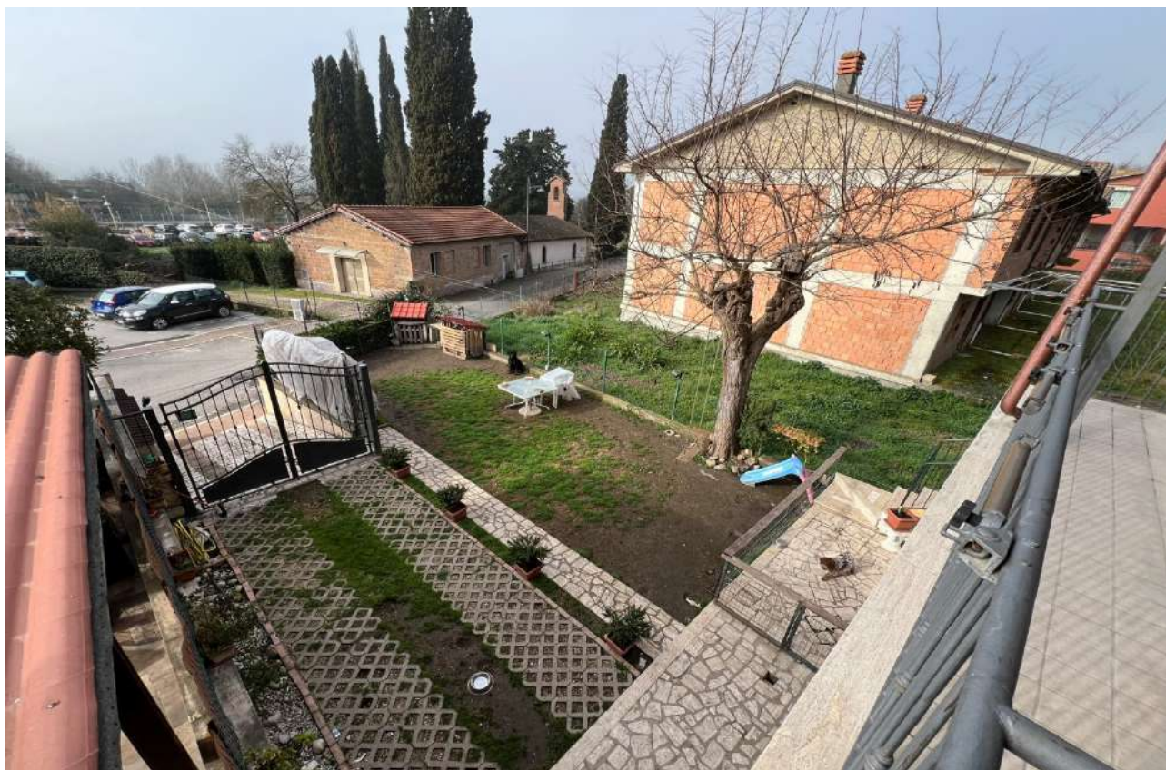
FOTO 2: Veduta sterna corte di pertinenza esclusiva prospetto sud-ovest
