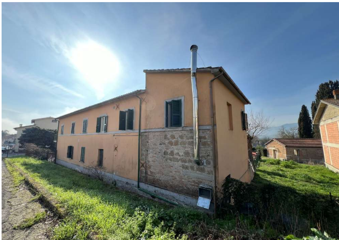
FOTO 3: Veduta esterna prospetto nord-est
