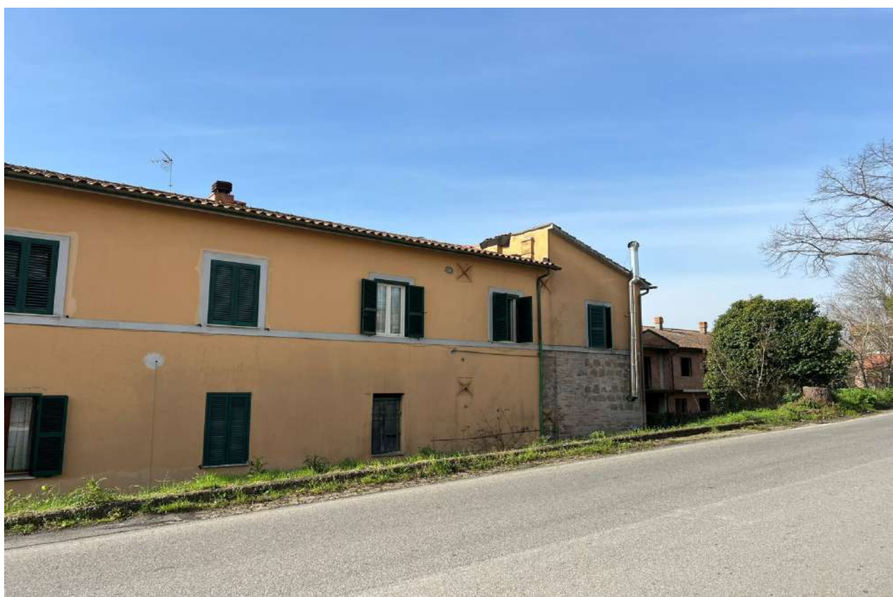
FOTO 4: Veduta esterna prospetto nord-est
