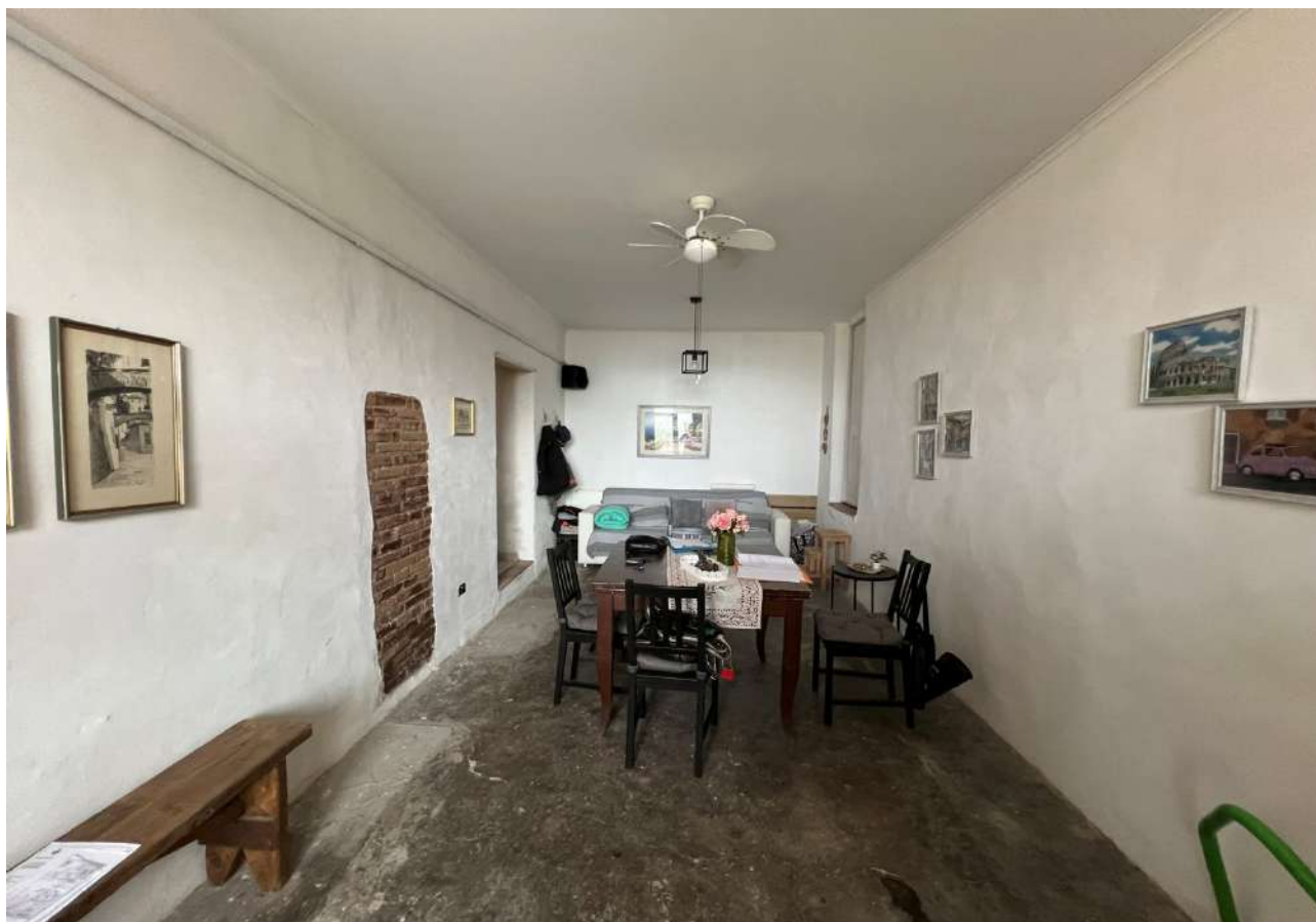
FOTO 7: Veduta interna vano soggiorno piano terra
