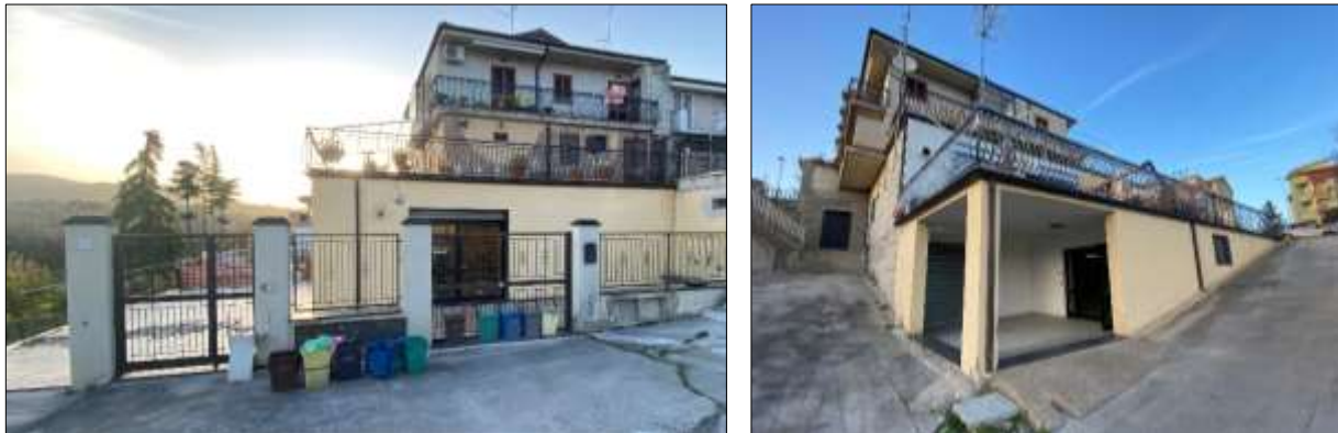
Fig. 4 – Foto degli esterni del fabbricato
