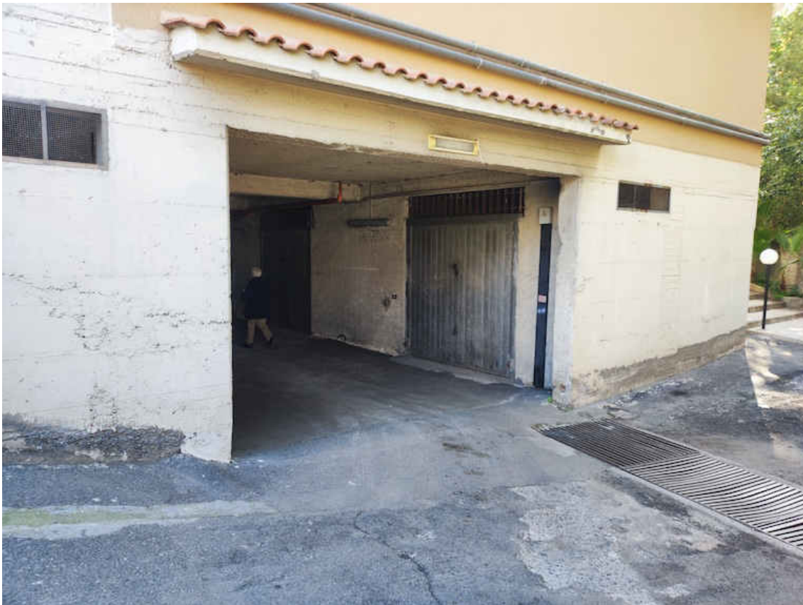
Vista ingresso corsia accesso alle autorimesse
