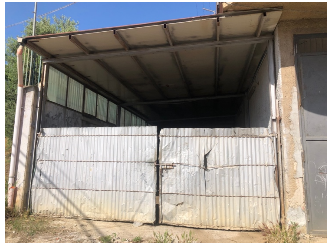
7. Particolare lamiera chiusura corte a sx
