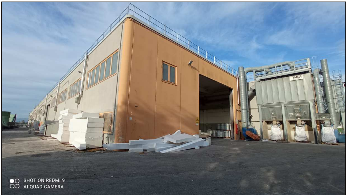
FOTO 2: VISTA GENERALE ESTERNA
