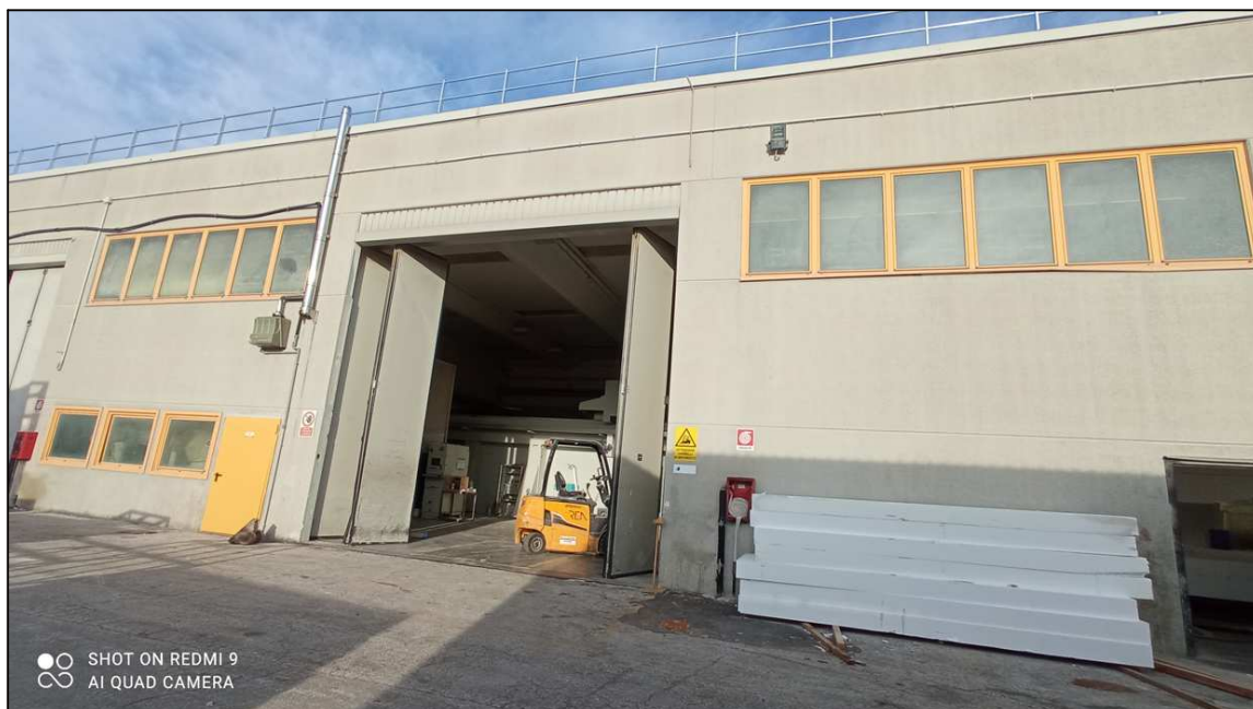
FOTO 6: PROSPETTO LATO LUNGO
