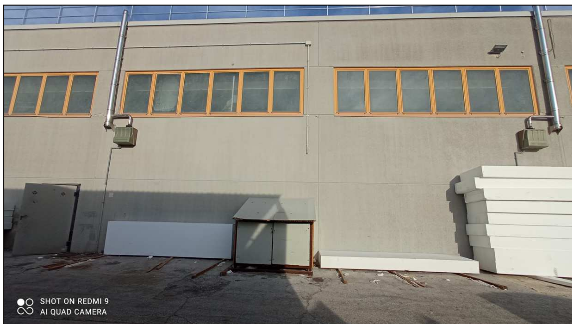
FOTO 4: PROSPETTO LATO LUNGO
