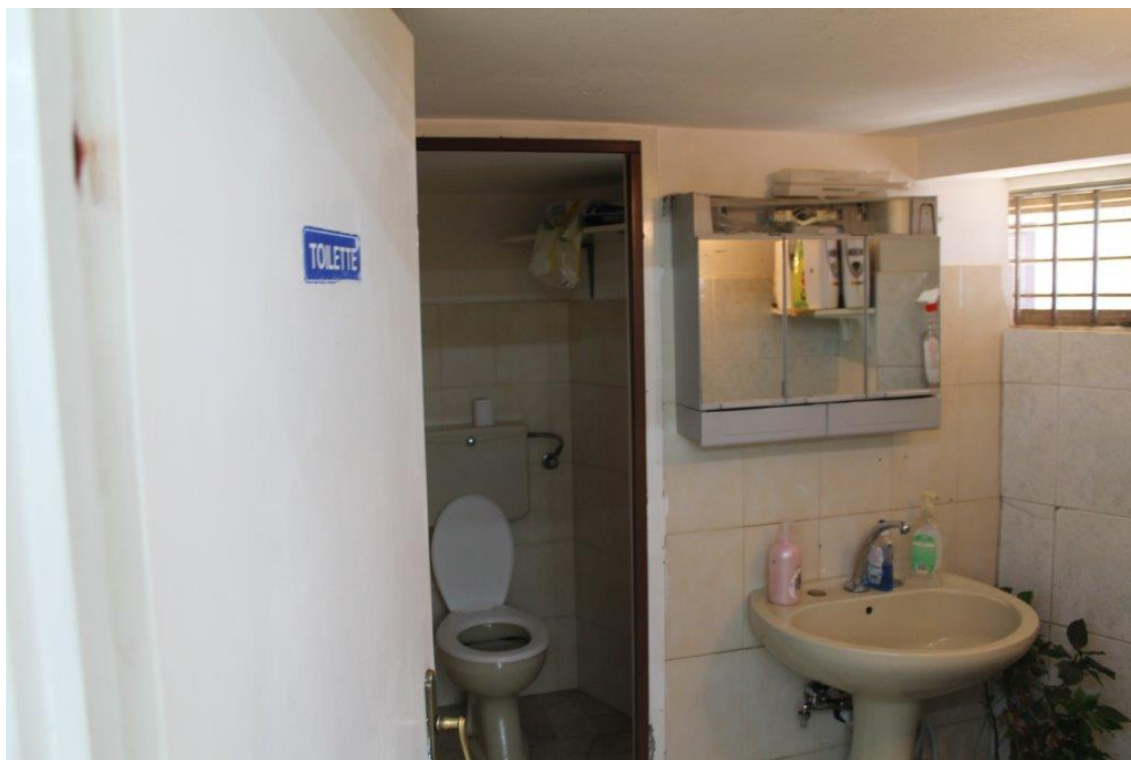
Foto 10 – Ambiente 5 (Disimpegno w.c.)
