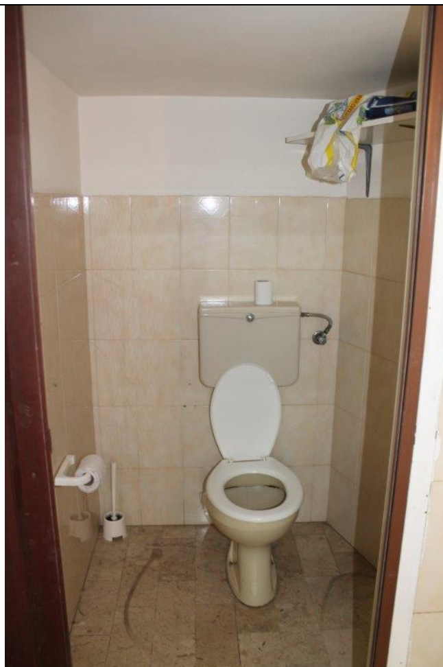
Foto 11 – Ambiente 6 (Disimpegno w.c.)
