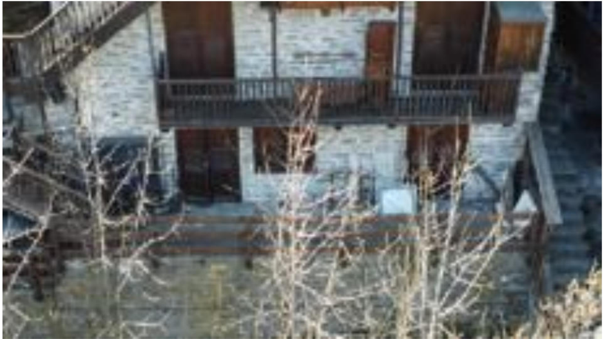
FACCIATA LATO NORD
