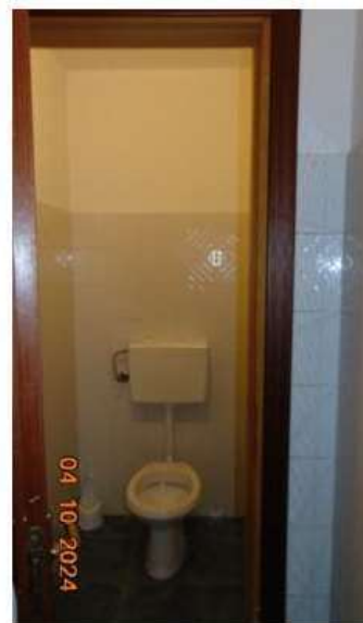
Lotto n. 1 - Foto 12 - Bagno
