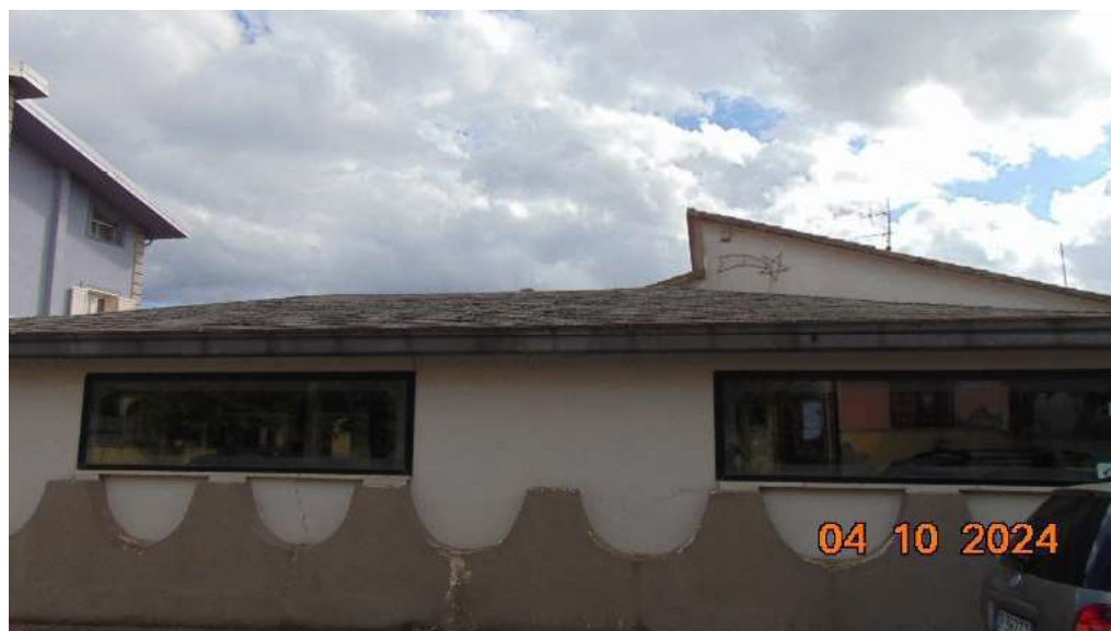
Lotto n. 1 - Foto 3 – Prospetto su strada provinciale
