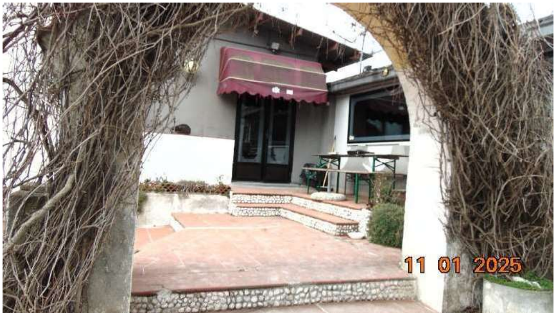
Lotto n. 1 - Foto 4 – Ingresso da strada privata
