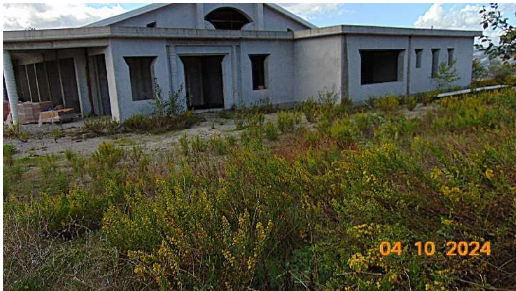
Lotto n. 4 - Foto 4 – Particolare fabbricato
