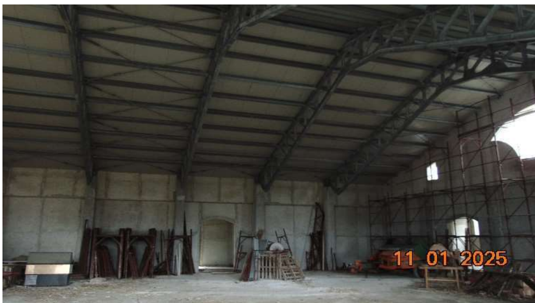
Lotto n. 4 - Foto 9 – Particolare copertura (vista interno)
