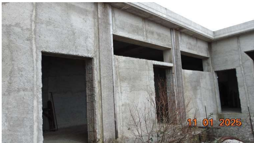
Lotto n. 4 - Foto 6 – Particolare murature
