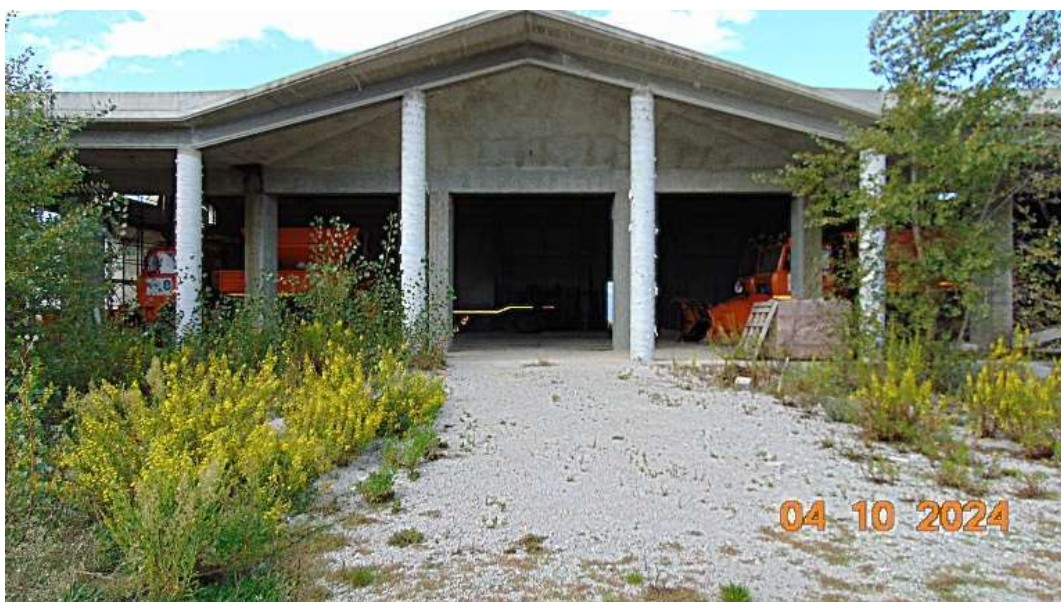
Lotto n. 4 - Foto 5 – Prospetto principale fabbricato
