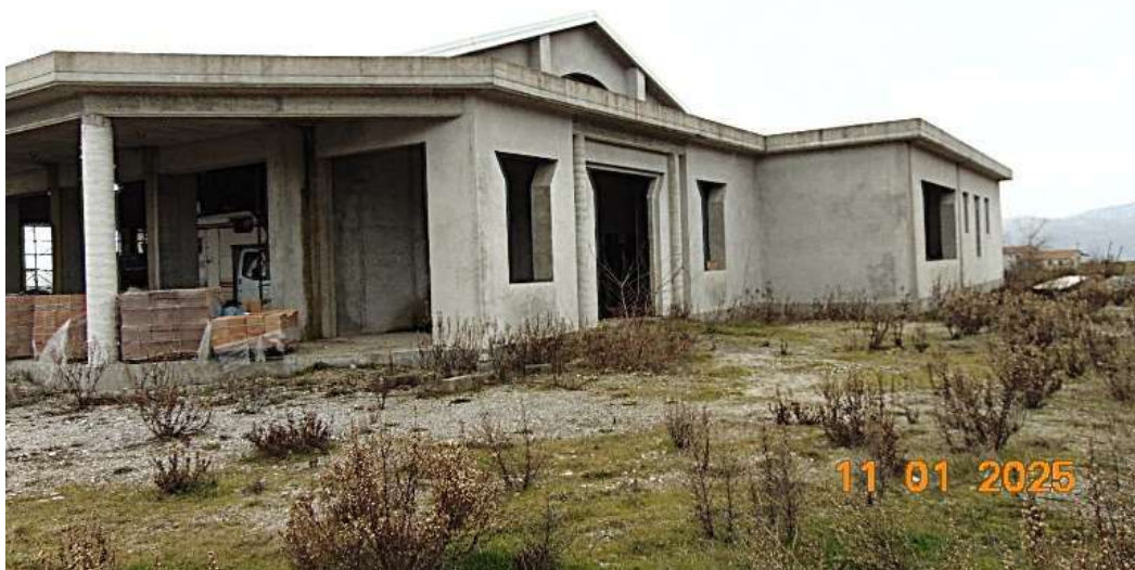
Lotto n. 4 - Foto 3 – Particolare fabbricato
