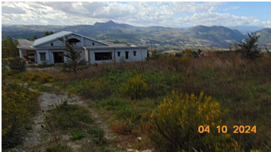
Lotto n. 4 - Foto 2 – Prospetto fabbricato lato monte
