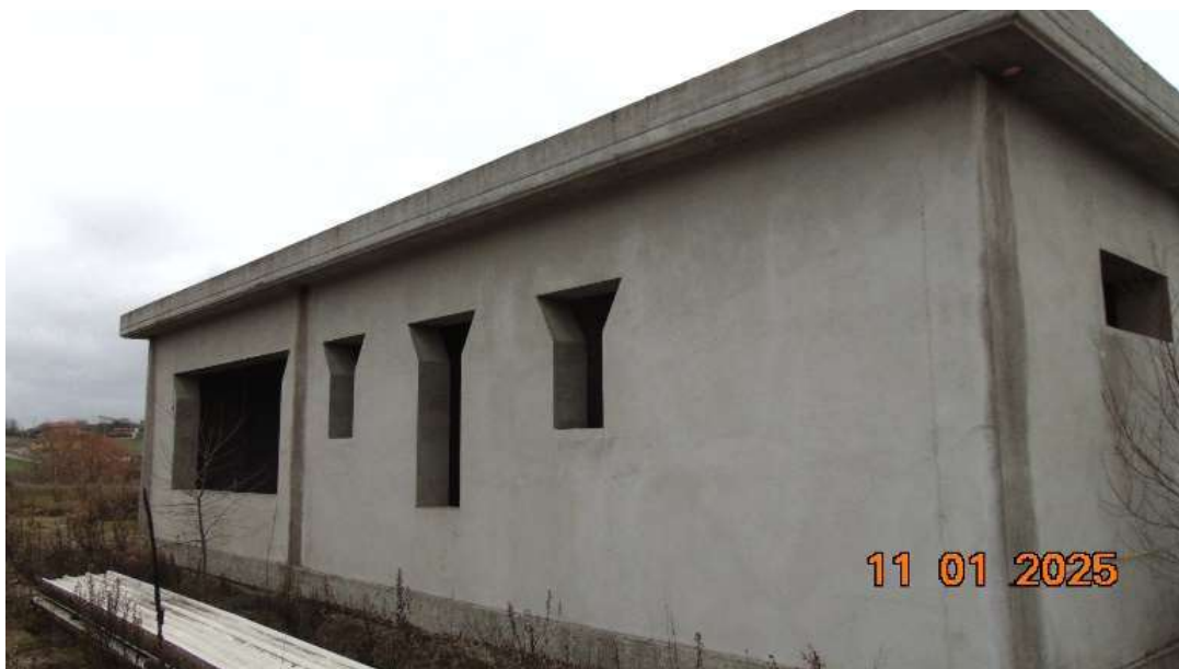
Lotto n. 4 - Foto 7 – Particolare murature
