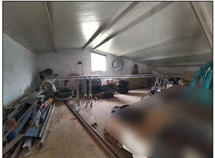
FOTO 127 - Lotto 2 - Corpo Z - Capannone (soppalco)
