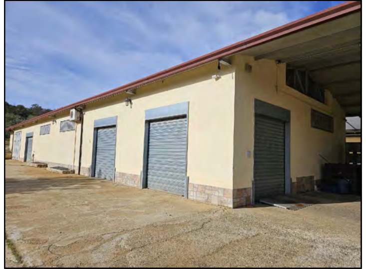
FOTO 117 - Lotto 2 - Corpo Z - Capannone (Esterni)
