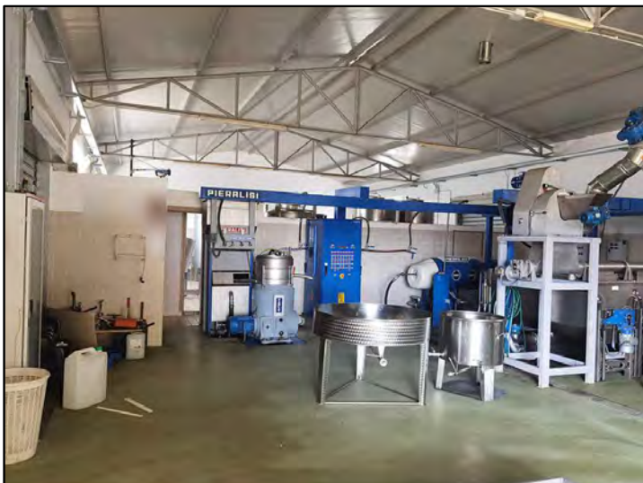
FOTO 120 - Lotto 2 - Corpo Z - Capannone (interni piano terra)
