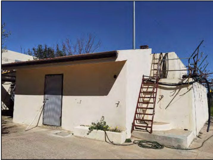
FOTO 173 - Lotto 2 - Corpo Z2 - Esterni
