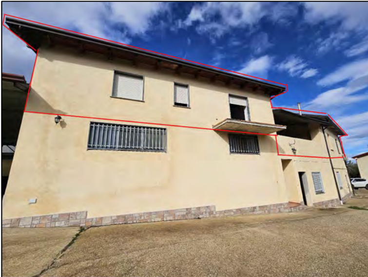
FOTO 87 - Lotto 2 - Corpo Y - Esterni
