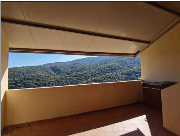
FOTO 91 - Lotto 2 - Corpo Y - Pianerottolo/terrazzo coperto
