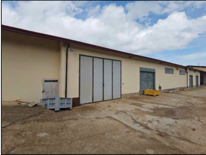
FOTO 116 - Lotto 2 - Corpo Z - Capannone (Esterni)
