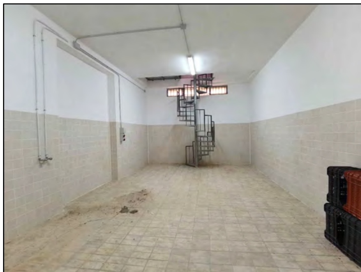
FOTO 129 - Lotto 2 - Corpo Z - Capannone (interni piano seminterrato)
