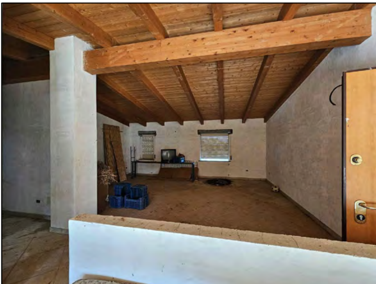
FOTO 108 - Lotto 2 - Corpo Y - Appartamento B (Soggiorno-Pranzo-Cucina)
