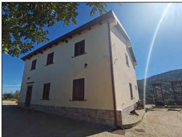
FOTO 66 - Lotto 2 - Corpo X - Esterni
