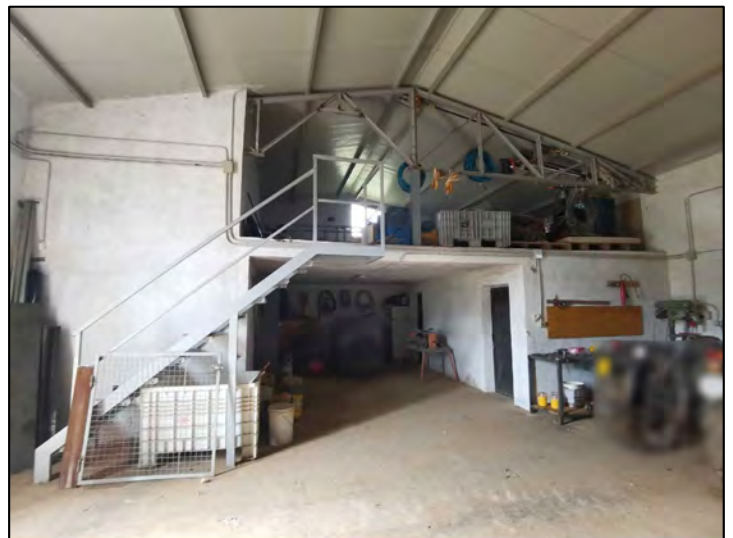
FOTO 121 - Lotto 2 - Corpo Z - Capannone (interni piano terra)
