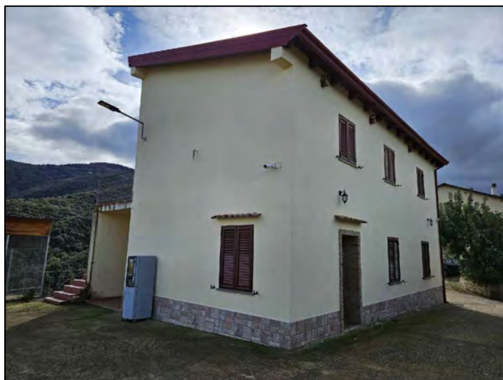
FOTO 67 - Lotto 2 - Corpo X - Esterni
