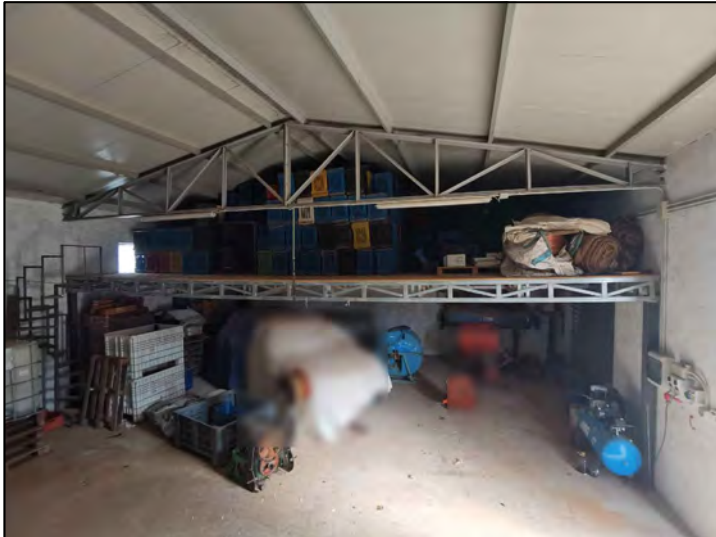
FOTO 124 - Lotto 2 - Corpo Z - Capannone (interni piano terra)
