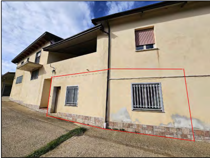
FOTO 164 - Lotto 2 - Corpo Z1 - Esterni
