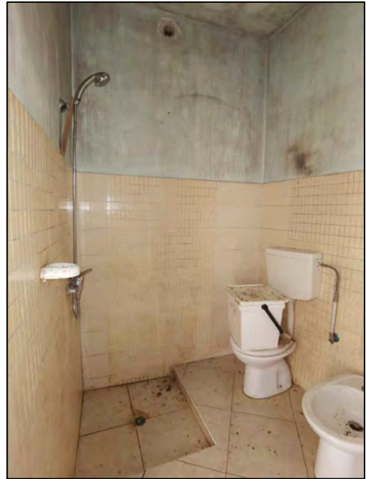
FOTO 171 - Lotto 2 - Corpo Z1 - Interni (Bagno)
