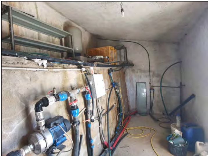
FOTO 175 - Lotto 2 - Corpo Z2 - Interni
