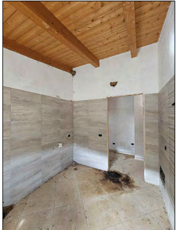
FOTO 112 - Lotto 2 - Corpo Y - Appartamento B (Bagno)
