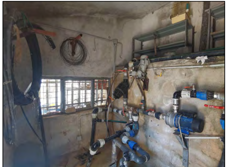
FOTO 176 - Lotto 2 - Corpo Z2 - Interni
