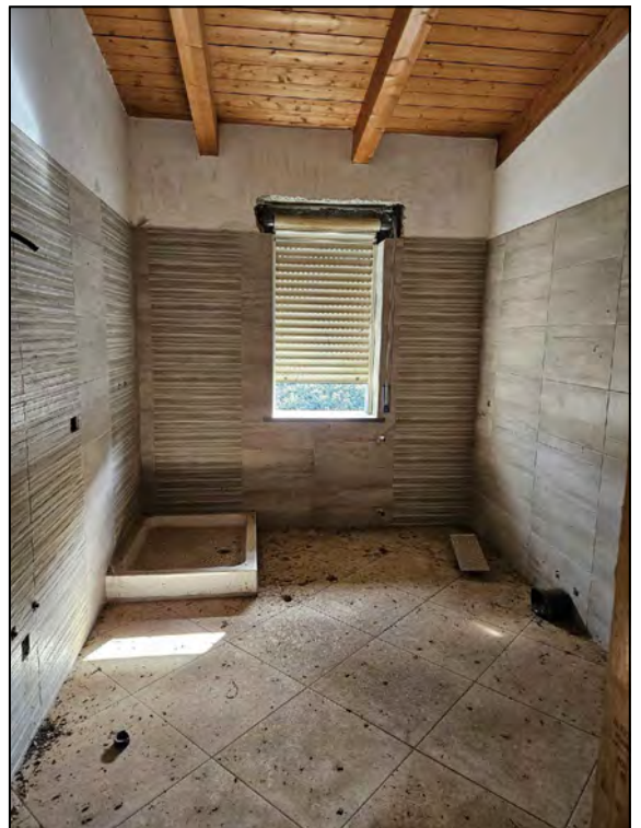
FOTO 114 - Lotto 2 - Corpo Y - Appartamento B (Bagno)
