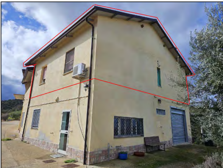
FOTO 89 - Lotto 2 - Corpo Y - Esterni
