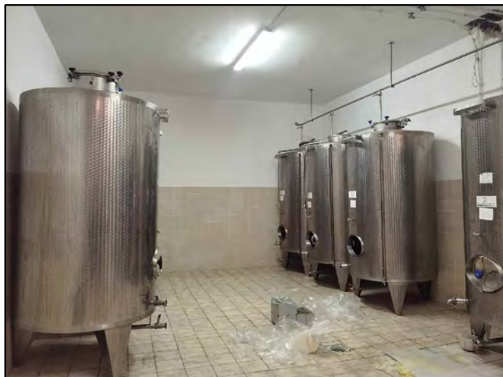
FOTO 130 - Lotto 2 - Corpo Z - Capannone (interni piano seminterrato)
