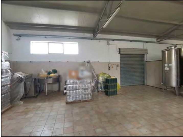
FOTO 122 - Lotto 2 - Corpo Z - Capannone (interni piano terra)
