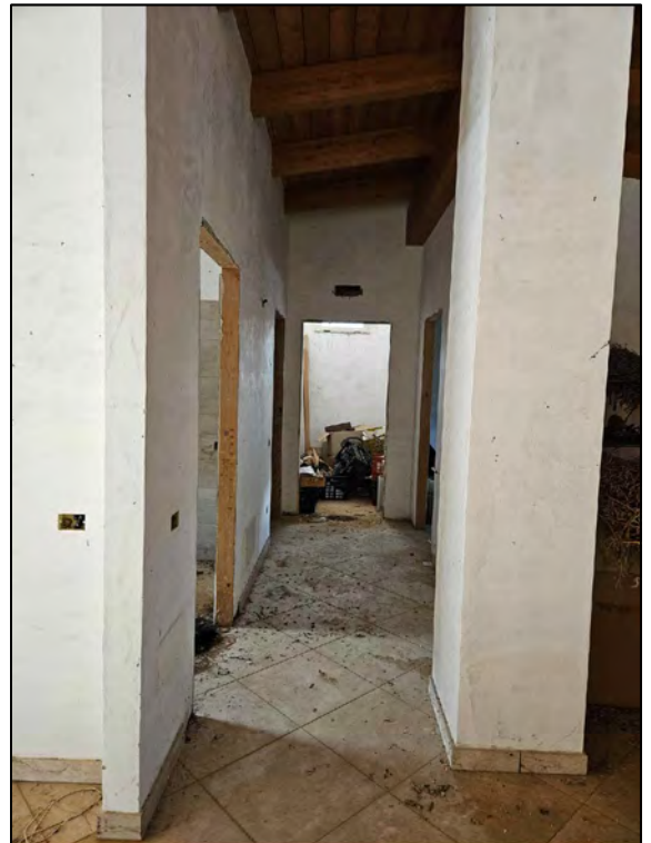
FOTO 105 - Lotto 2 - Corpo Y - Appartamento B (Corridoio)
