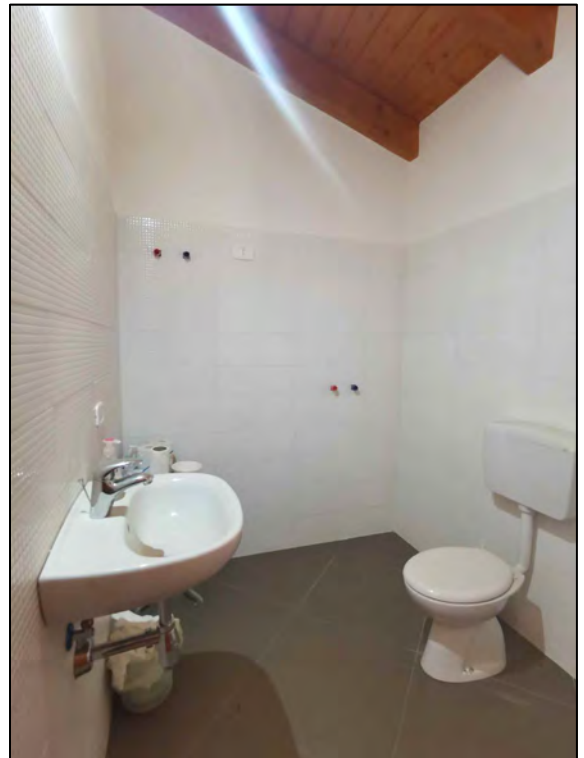
FOTO 83 - Lotto 2 - Corpo X - Bagno (Piano Primo)
