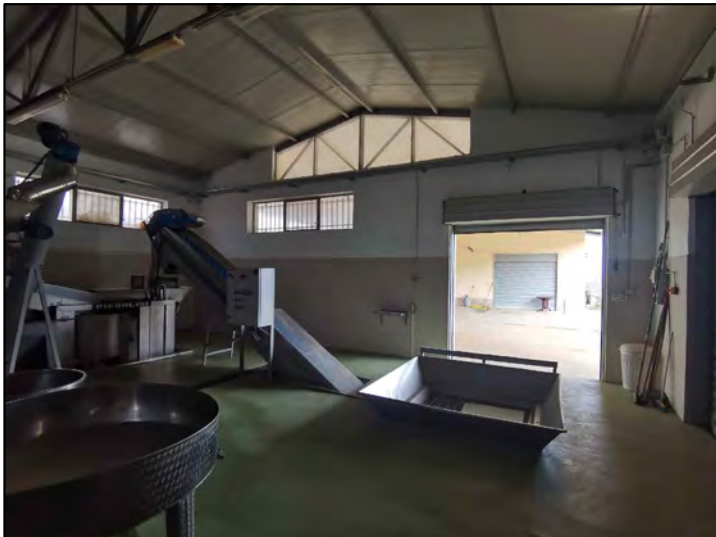
FOTO 118 - Lotto 2 - Corpo Z - Capannone (interni piano terra)
