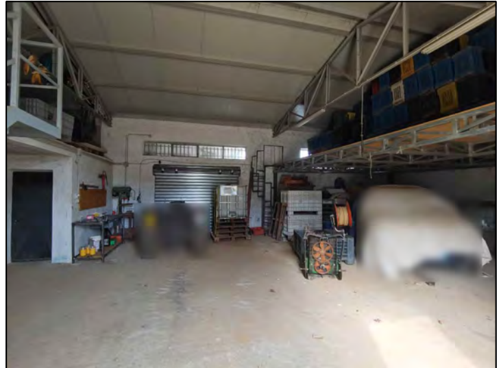
FOTO 125 - Lotto 2 - Corpo Z - Capannone (interni piano terra)
