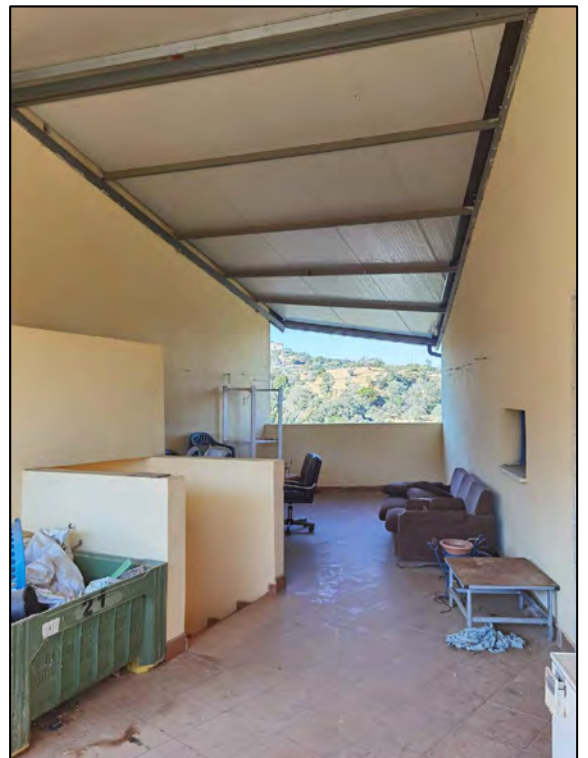
FOTO 90 - Lotto 2 - Corpo Y - Pianerottolo/terrazzo coperto
