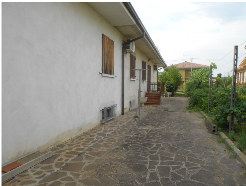
Fig. 13 Vista fianco sx da nord
