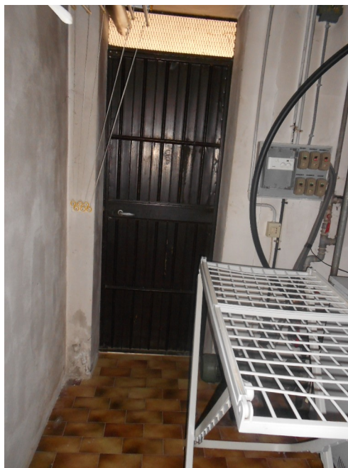
Fig. 44 Vista porta locale caldaia verso accesso esterno
