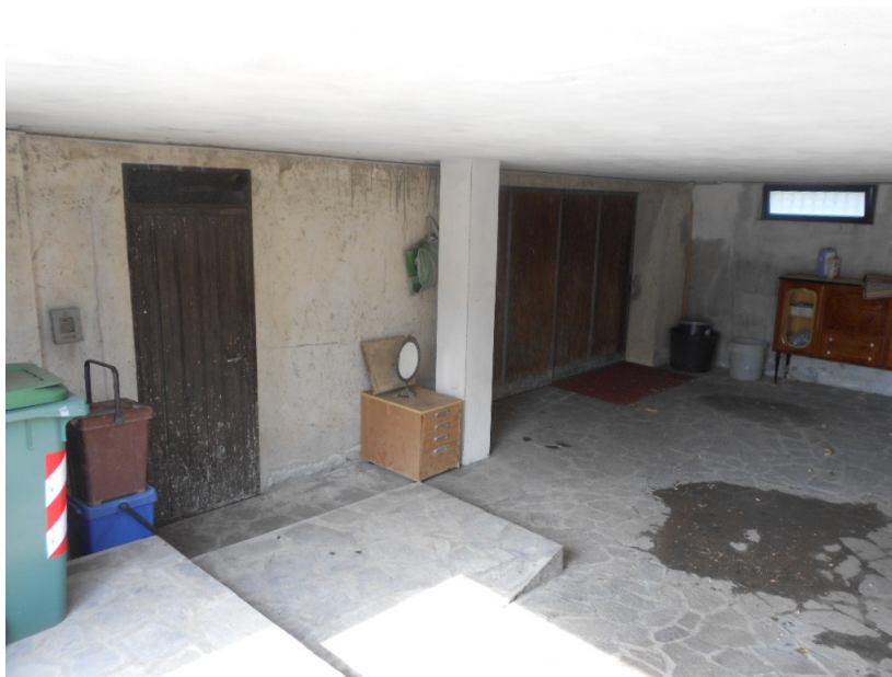
Fig. 17 vista porta locale caldaia e portone garage nel seminterrato.
