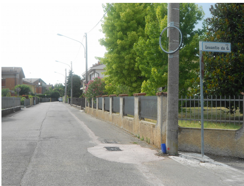
Fig. 2 vista della strada Levantio.
