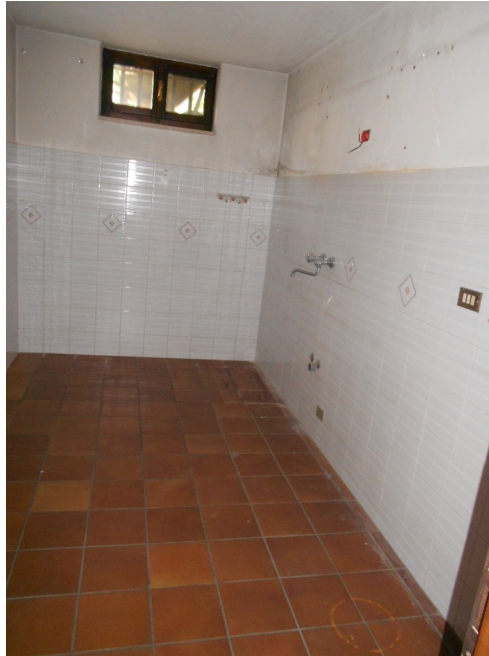
Fig. 33 Vista locale cucina nel seminterrato.
