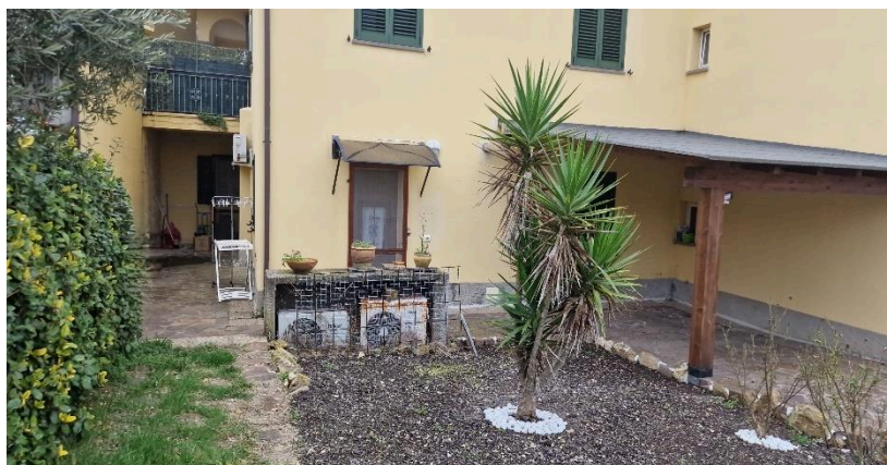
AREA DI CORTE DI PERTINENZA ESCLUSIVA DEL SUBALTERNO 4, PRESENZA DI MANUFATTI A SERVIZIO DEGLI ALTRI SUBALTERNI DI CUI TETTOIA IN LEGNO E MOTORI POMPE DI CALORE
