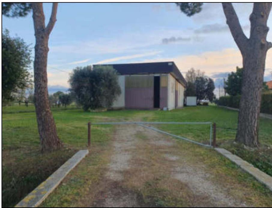
FOTO 1 - Vista fronte del fabbricato
