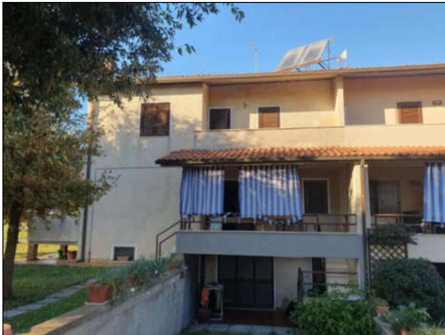
Vista retro del fabbricato
