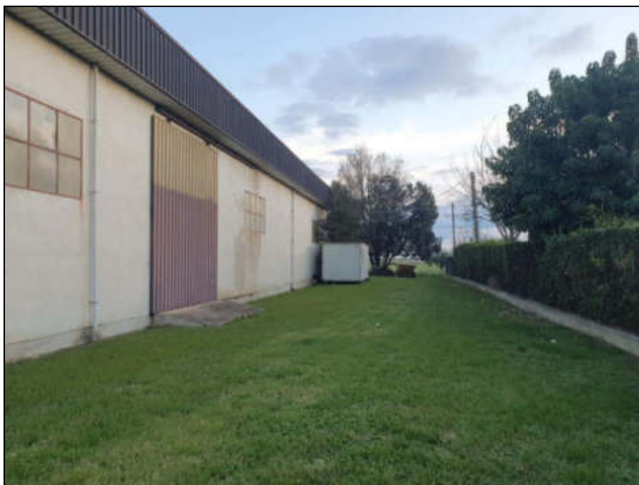
FOTO 3 - Vista lato nord-ovest del fabbricato
