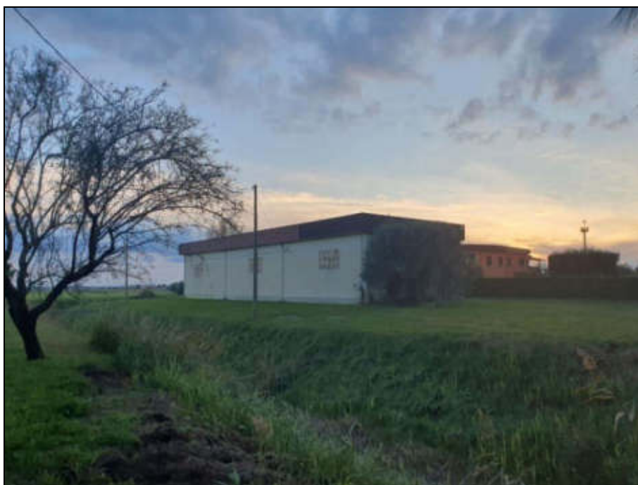
FOTO 2 - Vista lato nord-est del fabbricato
