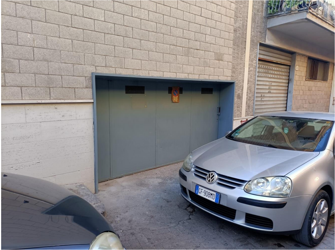
Vista ingresso del vano seminterrato dalla Via Santa Rita
