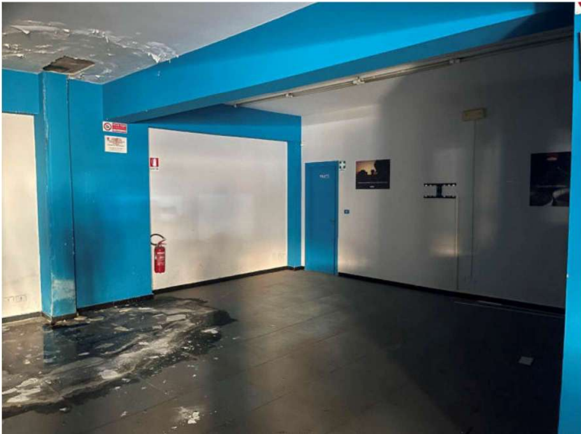
Foto 8-9 – Vista interna dell'unità immobiliare
