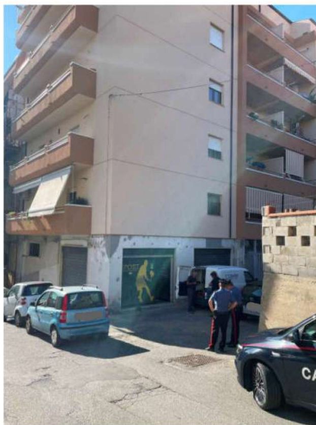
Foto 1-2 – Vista esterna dell'unità immobiliare
