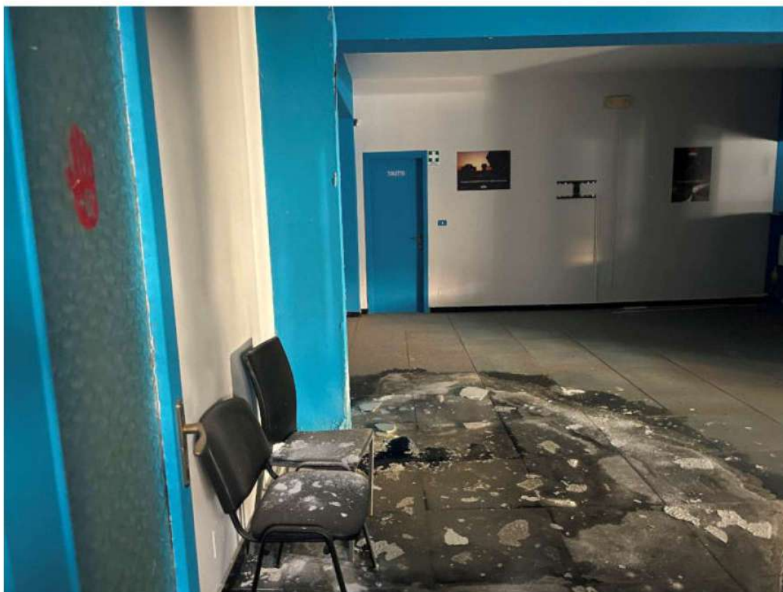
Foto 10-11 – Vista interna dell'unità immobiliare
