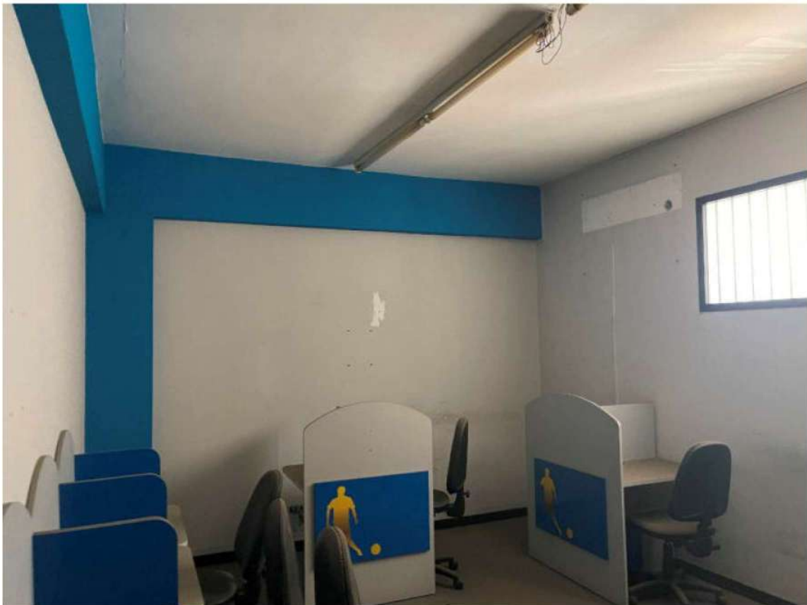
Foto 12-13 – Vista interna dell'unità immobiliare
