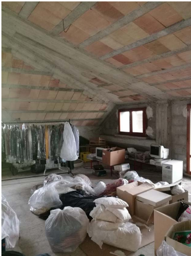
- Soffitta piano sottotetto
