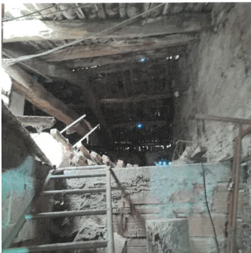
Vista interna locale sottotetto
