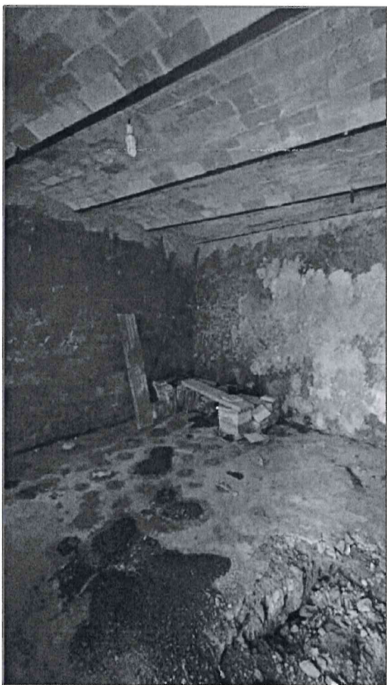
15 - Interno della cantina vista dall'ingresso
