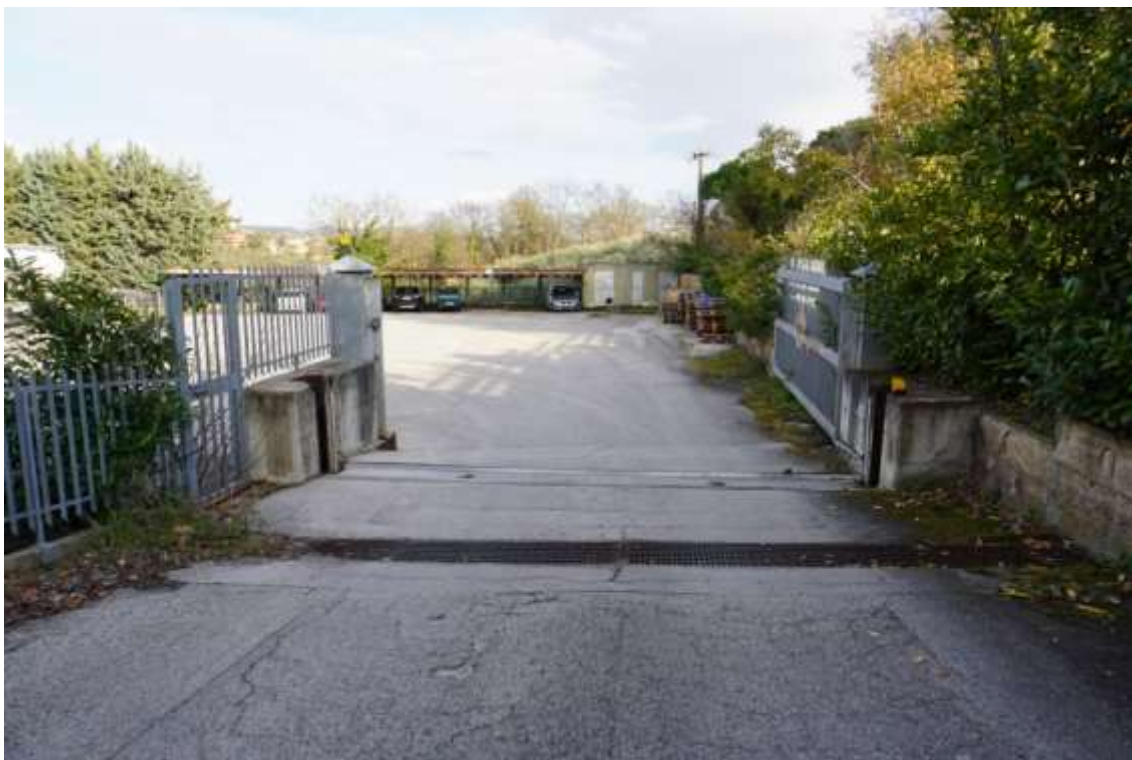
Fig.31 – Vista su accesso all'area esterna posteriore accatastata come sub.16 (BCNC)
