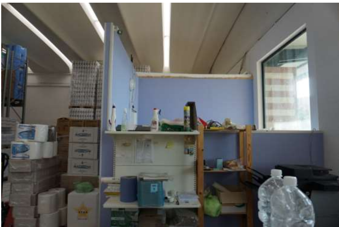
Fig.25 – Vista vano interno sub.18 (C1)
