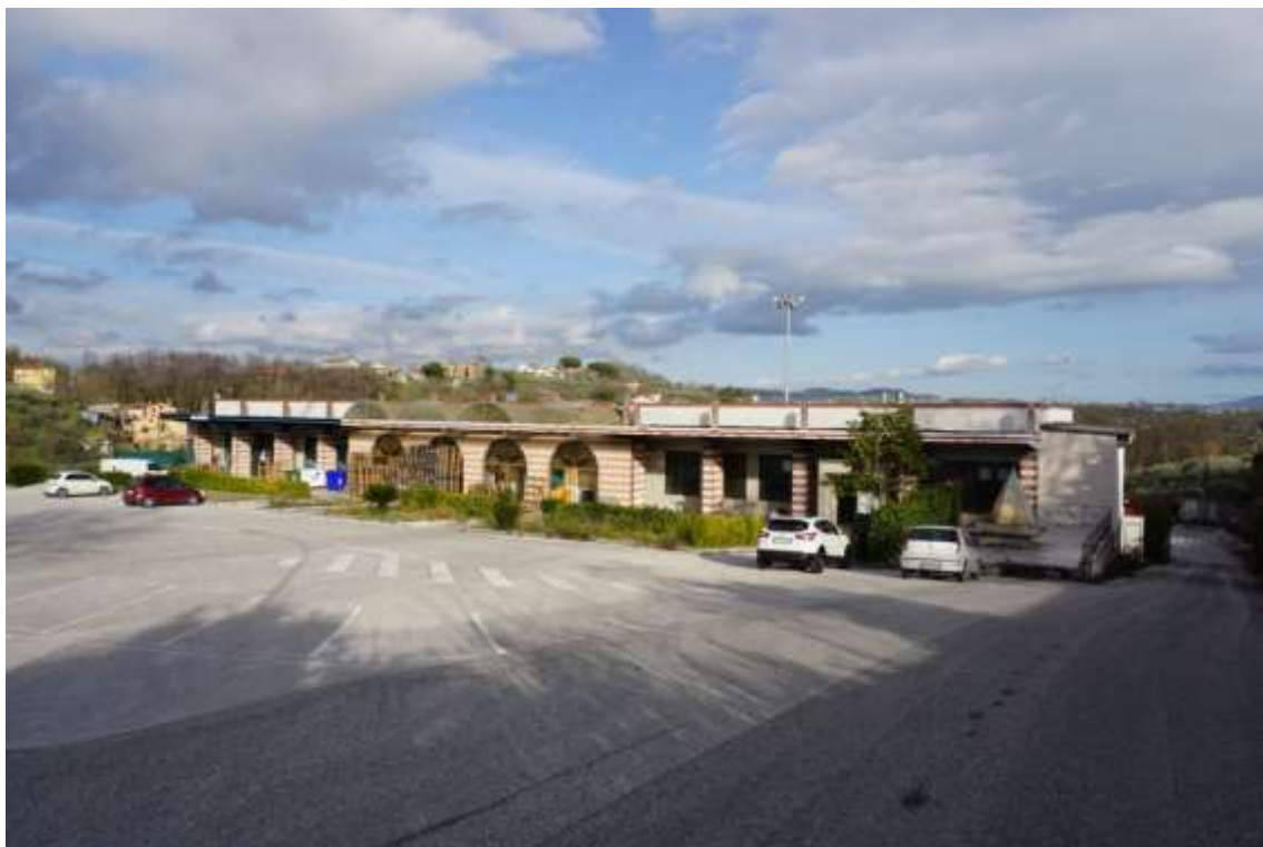
Fig.4 – Vista dello spiazzo esterno accatastato come sub. 17-18
