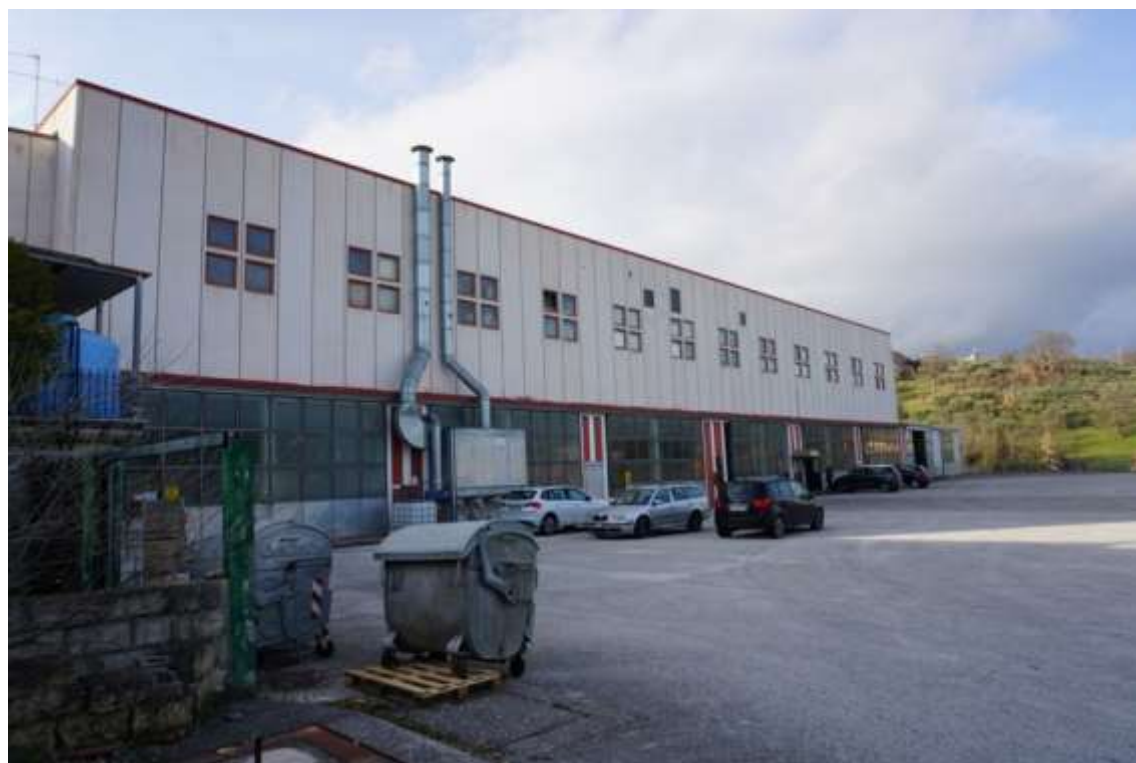
Fig.34 – Vista da sub.16 verso i sub.5-6-7-13
