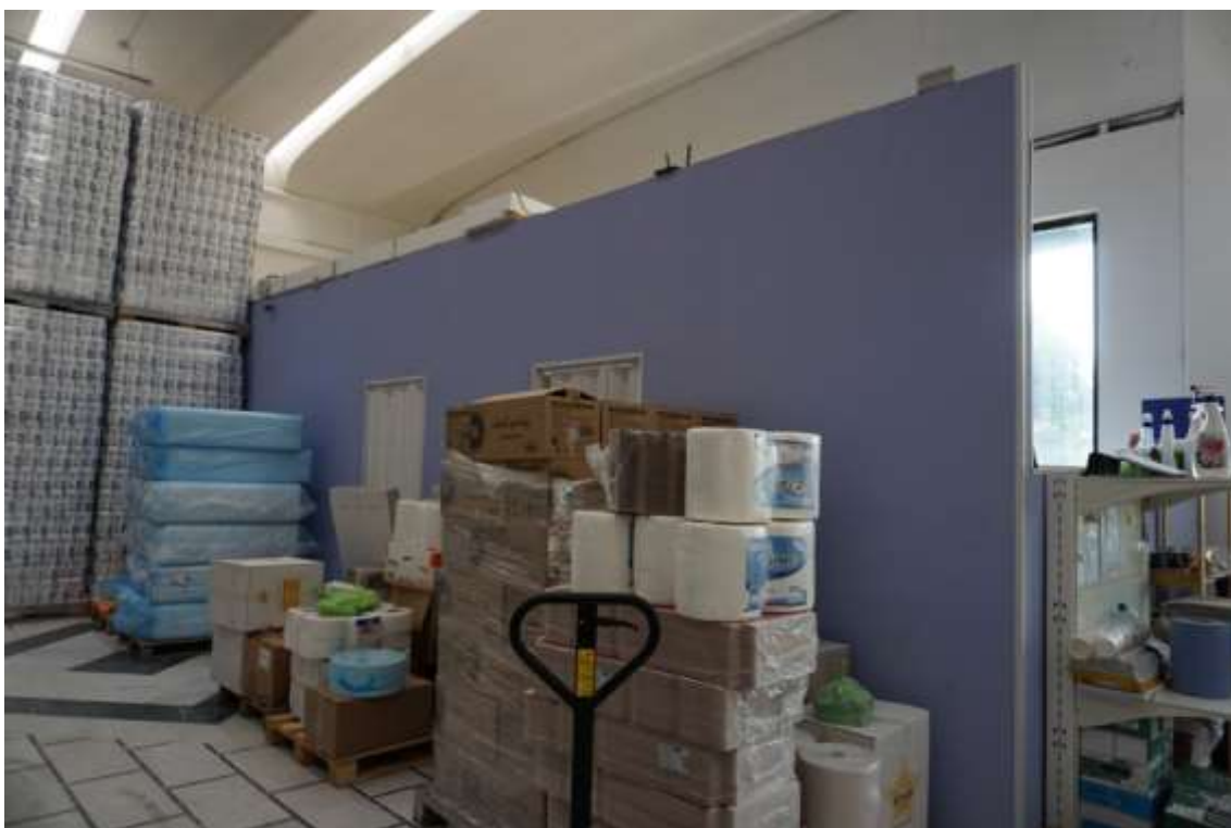
Fig.24 – Vista vano interno sub.18 (C1)
