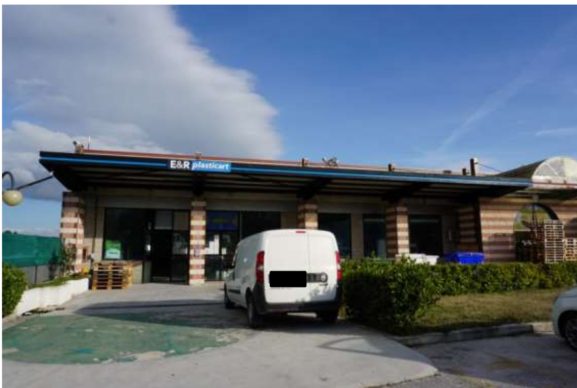
Fig.14 – Vista ingresso dell'immobile sub.18 (C1)
