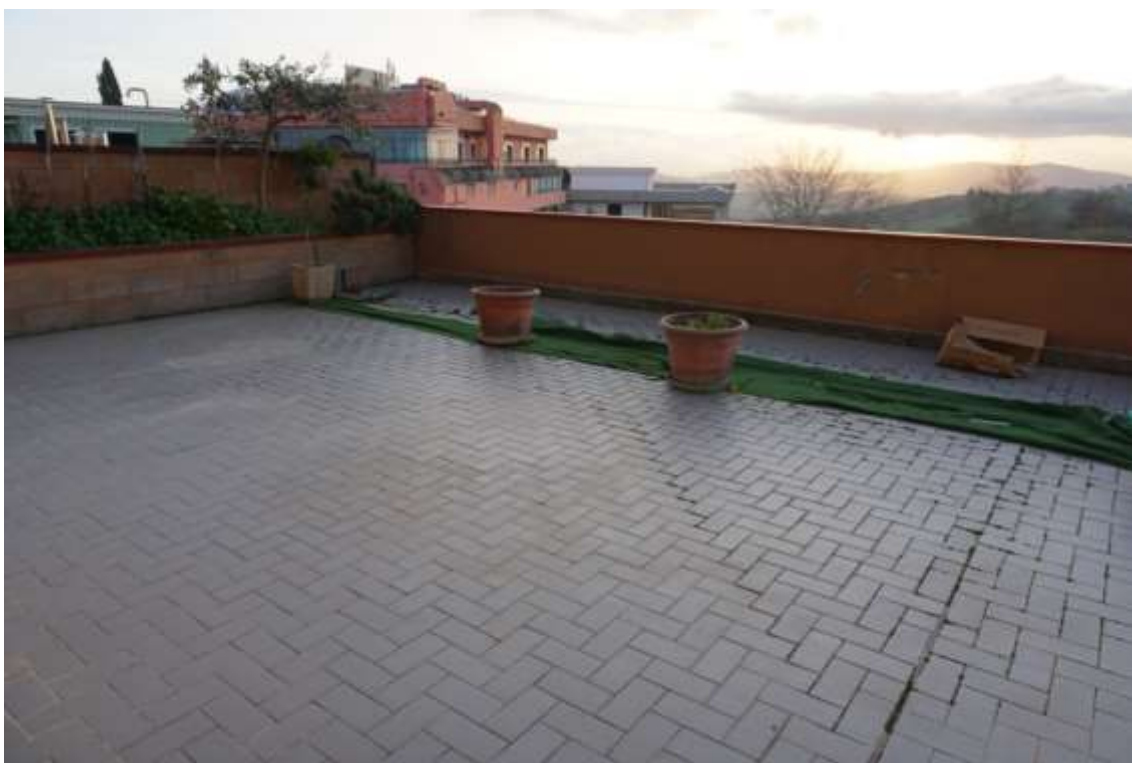
Fig.88 – Vista del terrazzo esposto ad ovest dell’immobile al sub.67 (A2)
