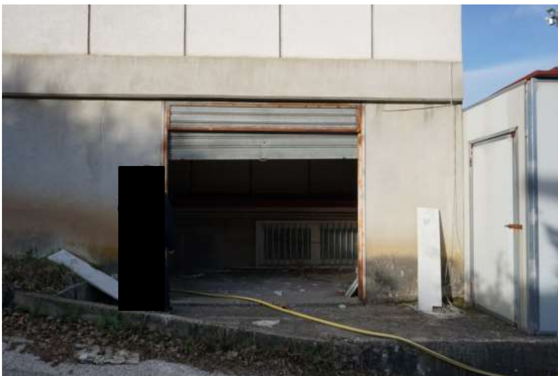
Fig.27 –Vista accesso all'immobile sub.12 (C2)
