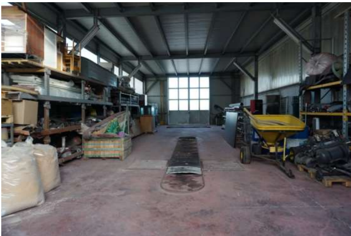
Fig.58 – Vista dell’immobile al sub.7 (D1)
