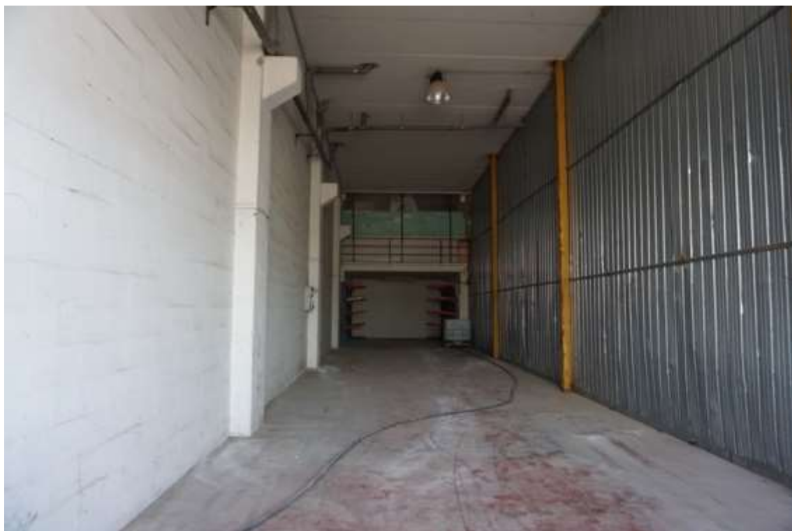
Fig.47 – Vista degli ambienti adibiti a deposito del sub.6 (C2)
