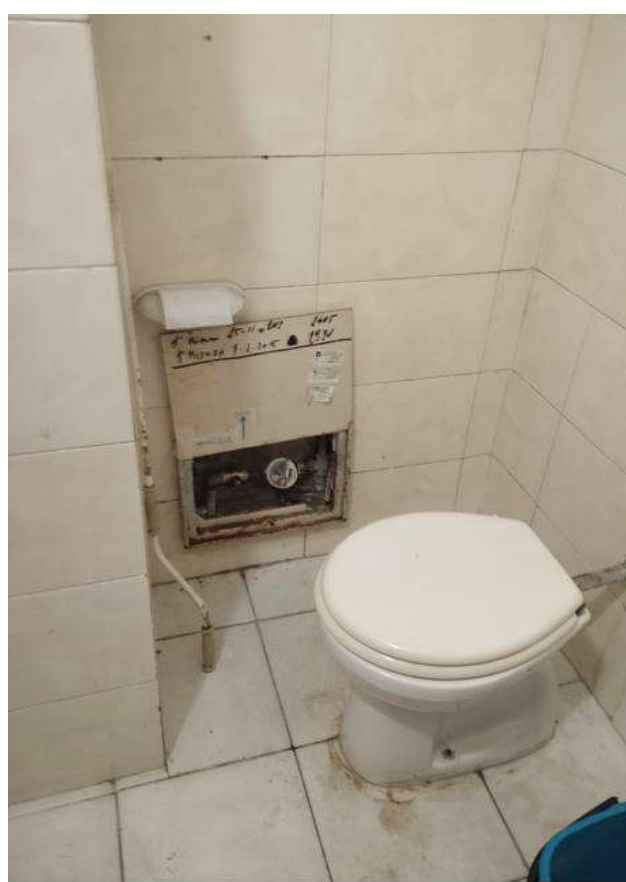
Foto 8 bagno di servizio
