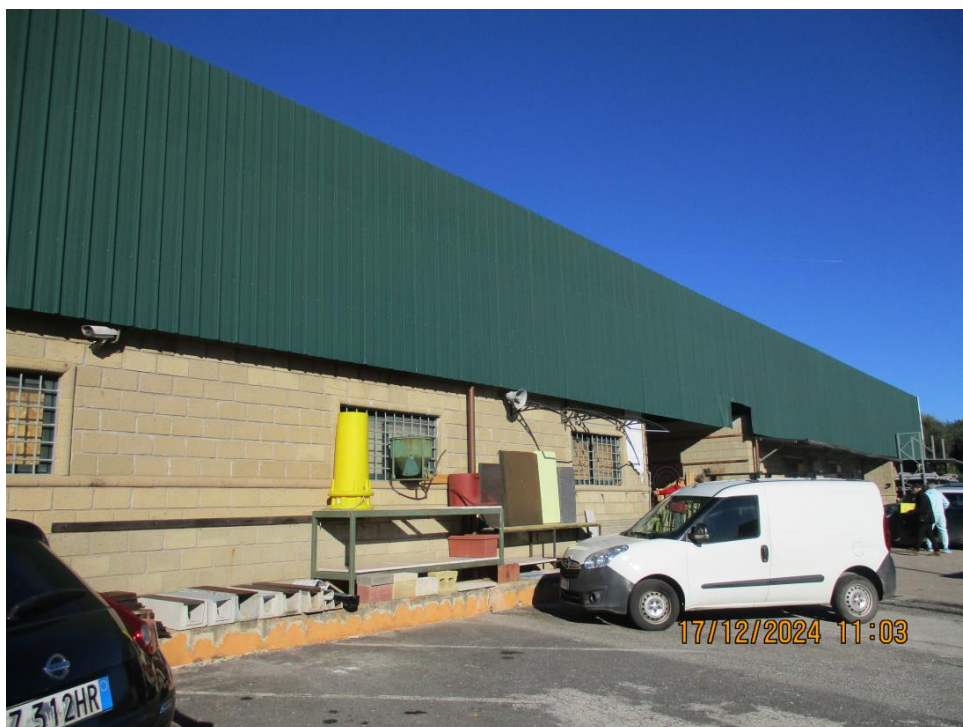
Vista esterna scorcio centrale dell'immobile Bene1 e Bene2
