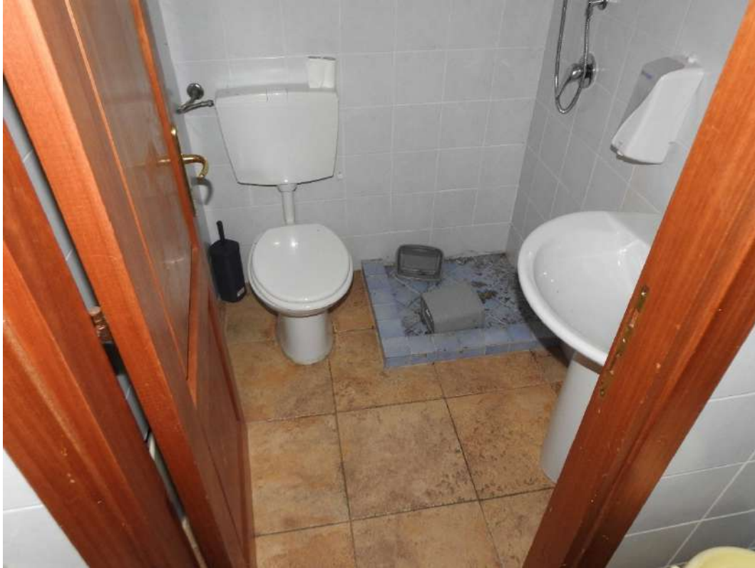
Figura 46 - Wc2, visuale dal relativo antibagno
