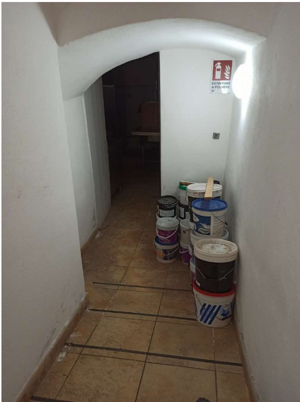
Figura 40 - Corridoio di collegamento verso la cucina. Vista verso la cucina, spalle al QEG
