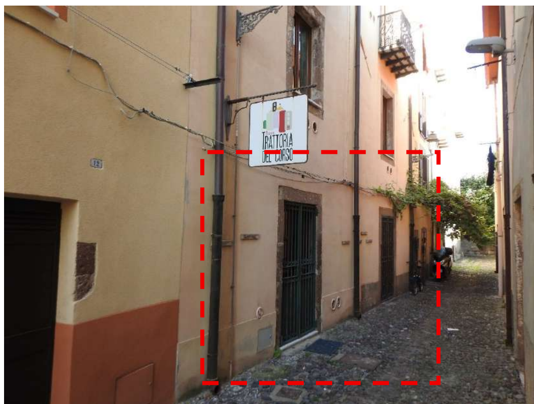
Figura 36 - Lotto 1, visuale esterna dalla via Santa Giusta
