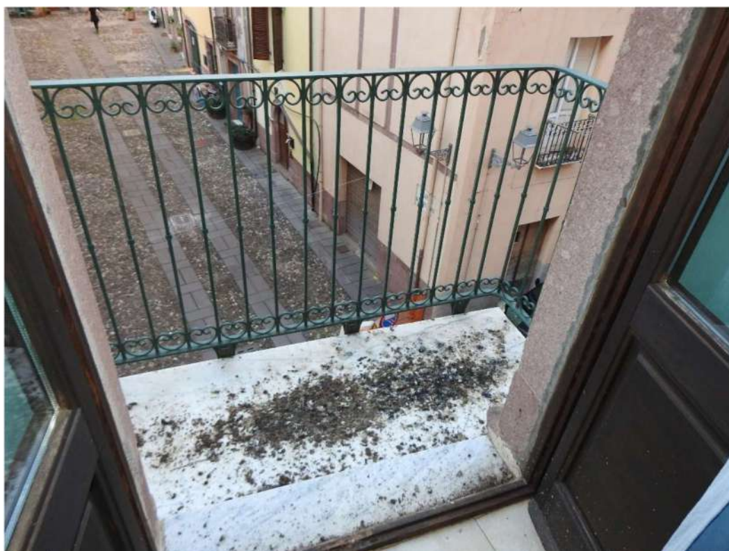
Figura 69 - Poggiolo camera interno 6
