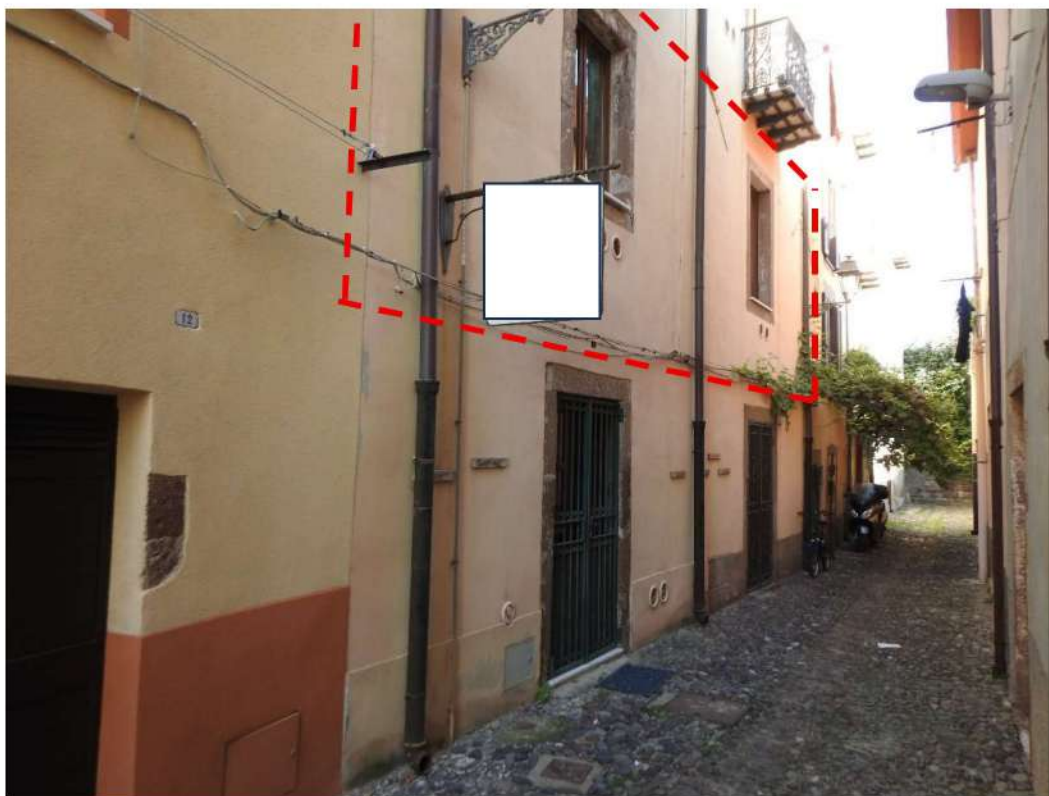
Figura 38 - Lotto 2, visuale esterna dalla via Santa Giusta
