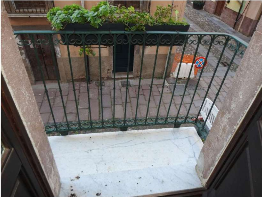
Figura 57 - Poggiolo soggiorno interno 3
