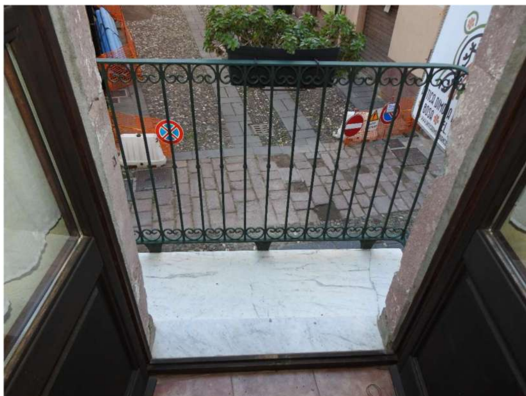
Figura 60 - Poggiolo camera 1 interno 3
