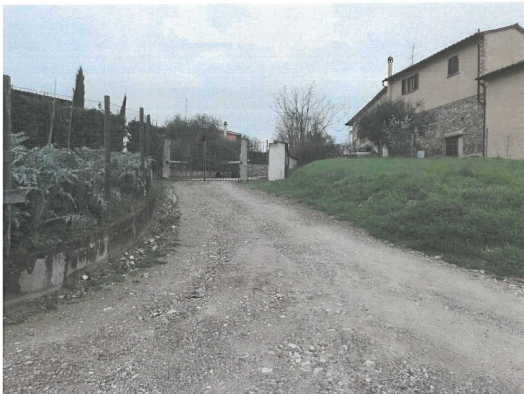
Foto 3: F35 P19 – Accesso condominiale da Via Mortelle n.7
