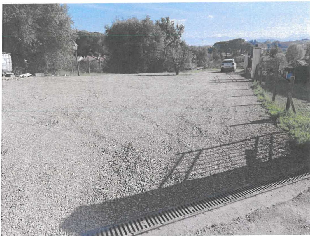
Foto 11: rifacimento di pavimentazione a ghiaia (Nov.2024) – corsello di manovra e posti auto
