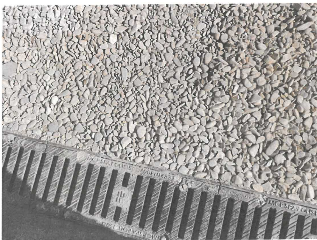
Foto 12: rifacimento di pavimentazione a ghiaia (Nov.2024) – corsello di manovra e posti auto
