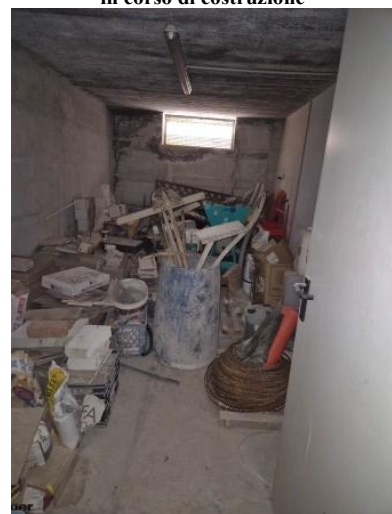
Figura 11 deposito 1 al piano seminterrato
