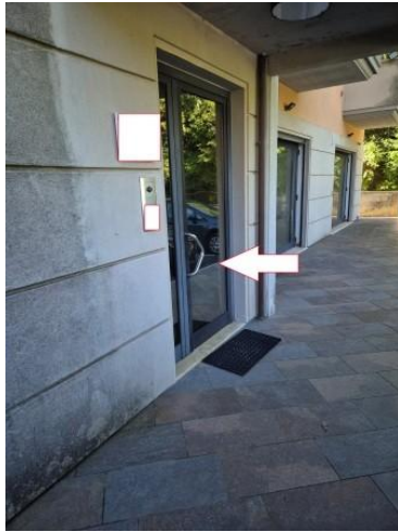
Figura 6 accesso al vano scala comune del fabbricato
