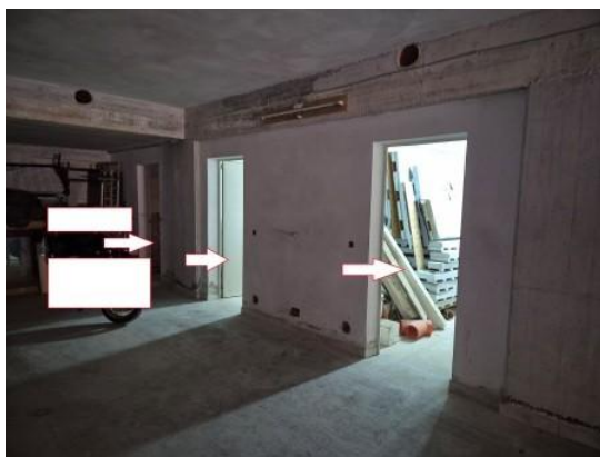
Figura 10 accesso ai tre depositi del piano seminterrato
