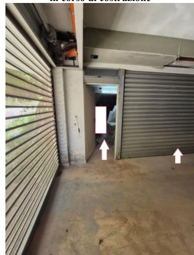
Figura 11 accesso al box auto del piano seminterrato
