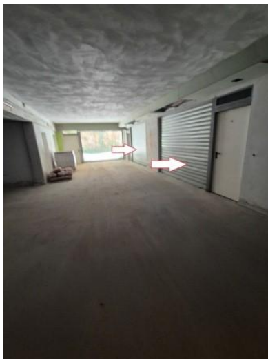
Figura 10 accesso al box auto del piano seminterrato
