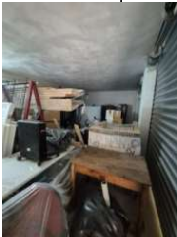
Figura 9 box auto al piano seminterrato
