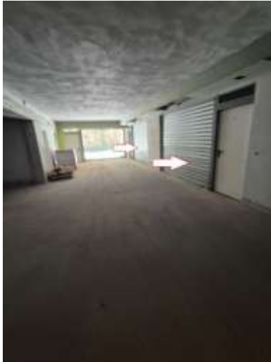
Figura 7 accesso al box auto del piano seminterrato
