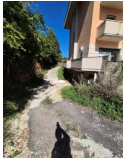
Figura 6 rampa carrabile per accesso al piano seminterrato in corso di costruzione
