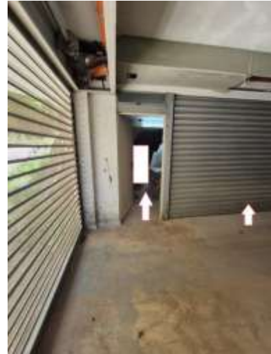
Figura 8 accesso al box auto del piano seminterrato
