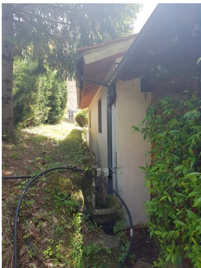
Foto n. 20 – Prospetto laterale fabbricato originario
