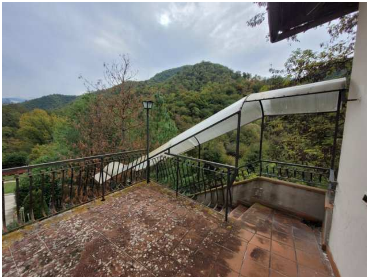
Foto n. 23 - Scala di accesso al P1 e alla terrazza
