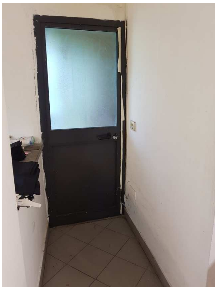
Foto n. 15 – Porta di accesso al retro del fabbricato
