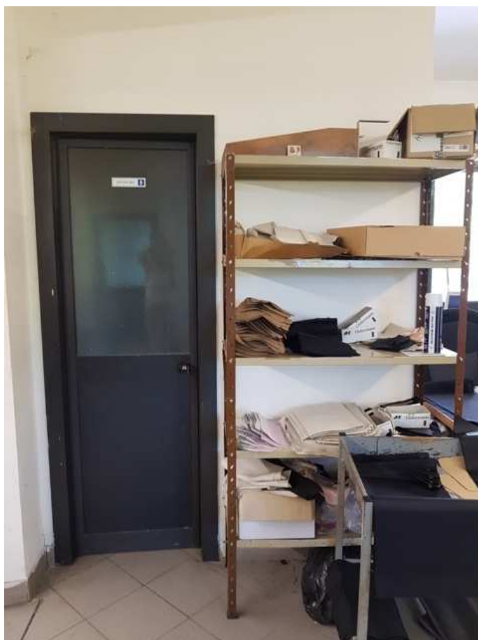
Foto n. 10 – Accesso al nuovo servizio igienico
