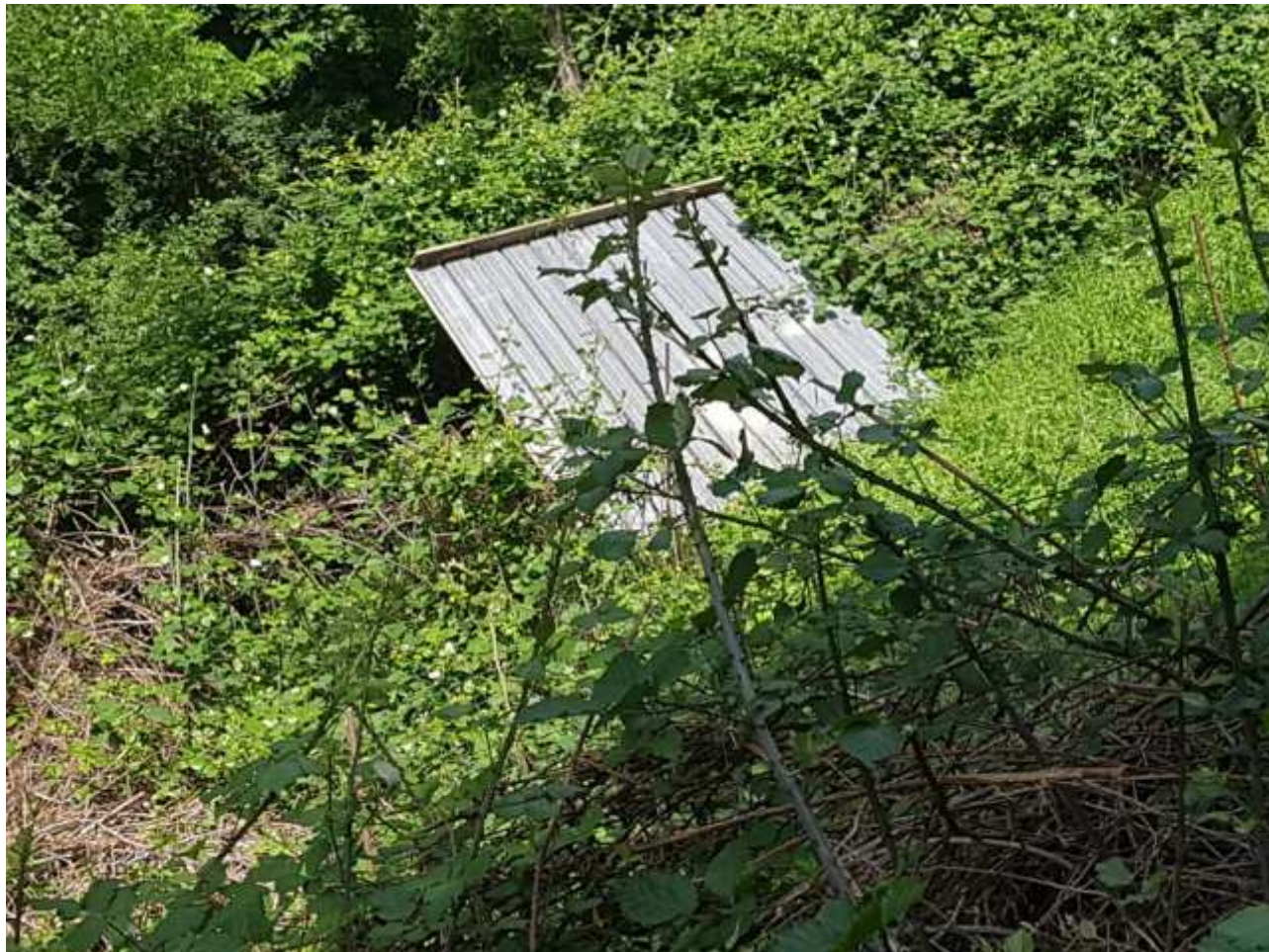
Foto n. 34 - Manufatto precario da rimuovere nel terreno
