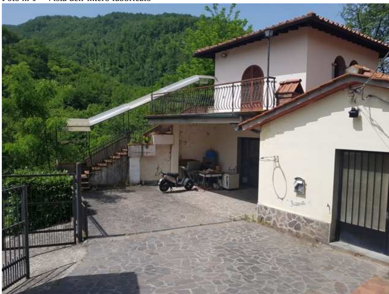
Foto n. 2 – Vista dell'ampliamento del fabbricato e scala di accesso al P1
