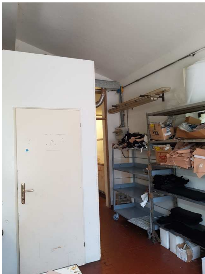
Foto n. 5 – Stanza di accesso del fabbricato originario
