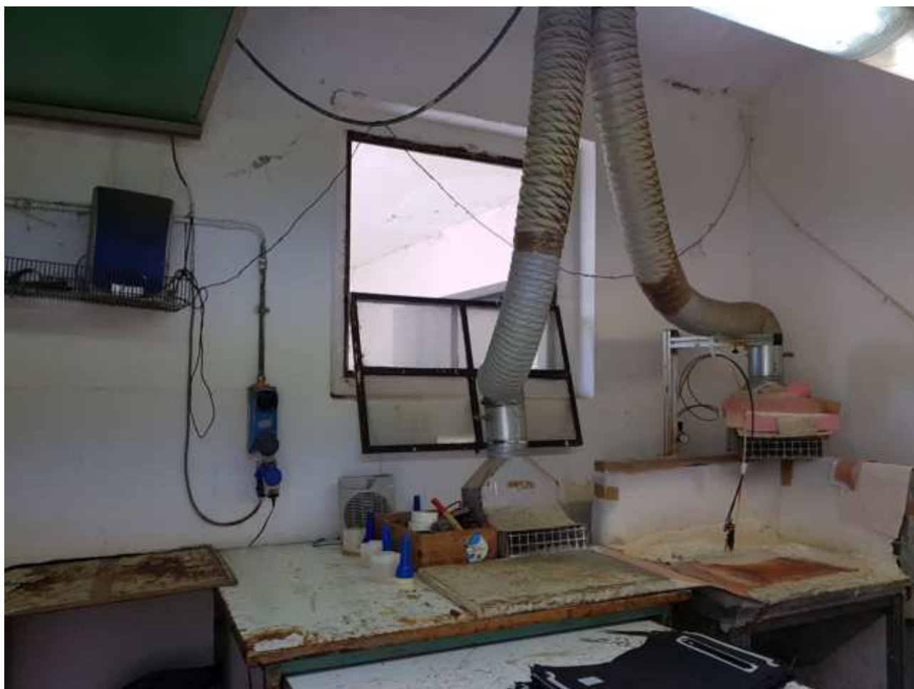
Foto n. 6 – Stanza di accesso del fabbricato originario
