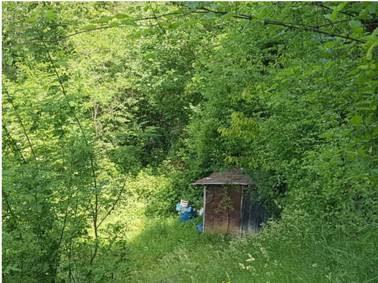
Foto n. 32– Manufatto precario da rimuovere nel terreno
