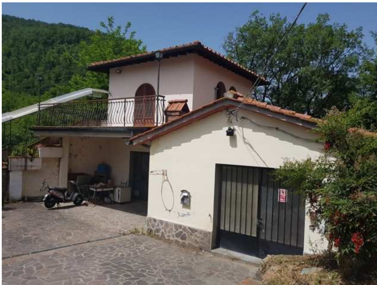
Foto n. 1 – Vista dell'intero fabbricato
