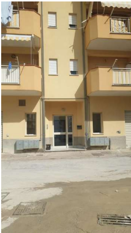
FOTO 2 - VEDUTA DEL PORTONE D'INGRESSO
