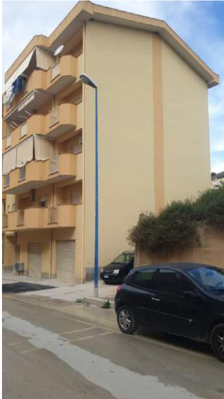
FOTO 4 - VEDUTA DEL PROSPETTO LATERALE
