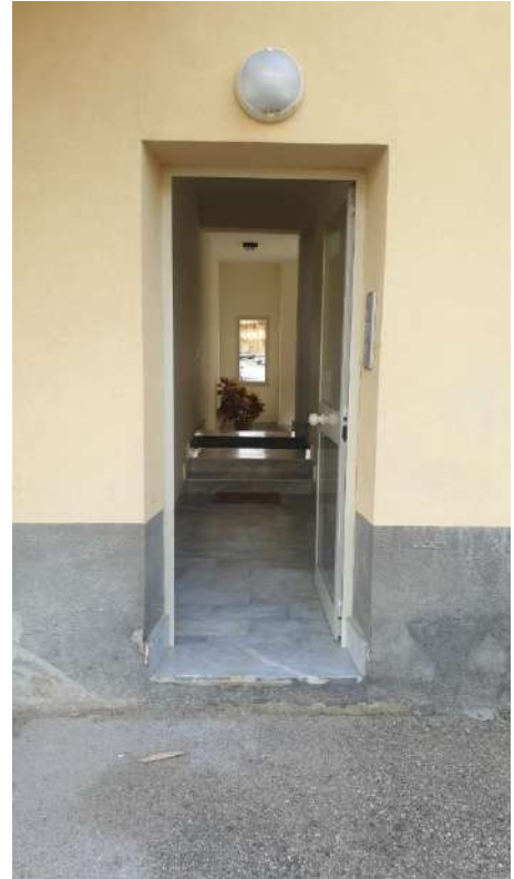
FOTO 5 - VEDUTA DELL'INGRESSO SECONDARIO
